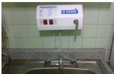
Figura 5.13. Ejemplo de equipo ozonador para tratamiento terciario del agua antes de su consumo.
