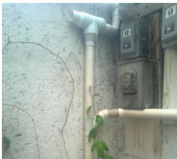
Figura 5.4. Separador de sólidos grandes modelo “b”, implementado con una malla metálica en forma cilíndrica dentro de una te de PVC con tapón.
