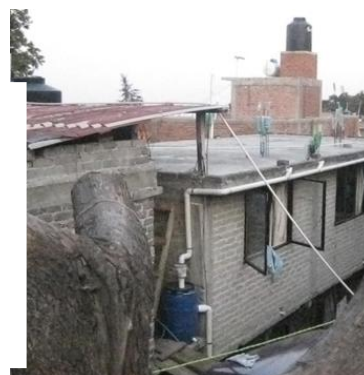
Figura 2.5. Sistema de captación de lluvia del proyecto Isla Urbana (Isla Urbana, 2011).
