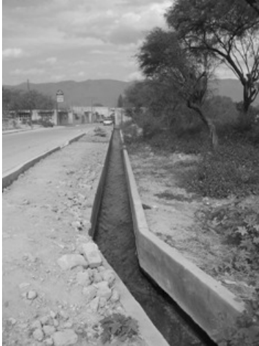
Foto 1. Vista del canal de riego
