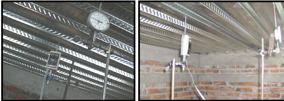
Figura 6.1 Instrumentos colocados en la parte inferior del sistema de piso Losa-acero para medir su comportamiento bajo la aplicación de carga
