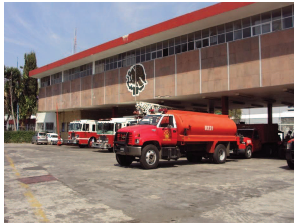
Fachada Principal de la Estación de Bomberos Central
