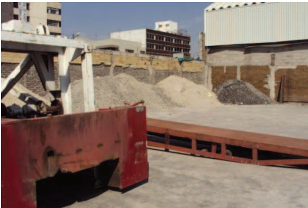
Frontón, espacio recreativo que se encuentra ocupado por material de construcción.
