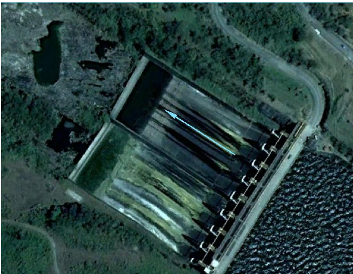
Figura 6.2 Fotografía del vertedor de Peñitas y socavación en la zona de impacto del chorro
