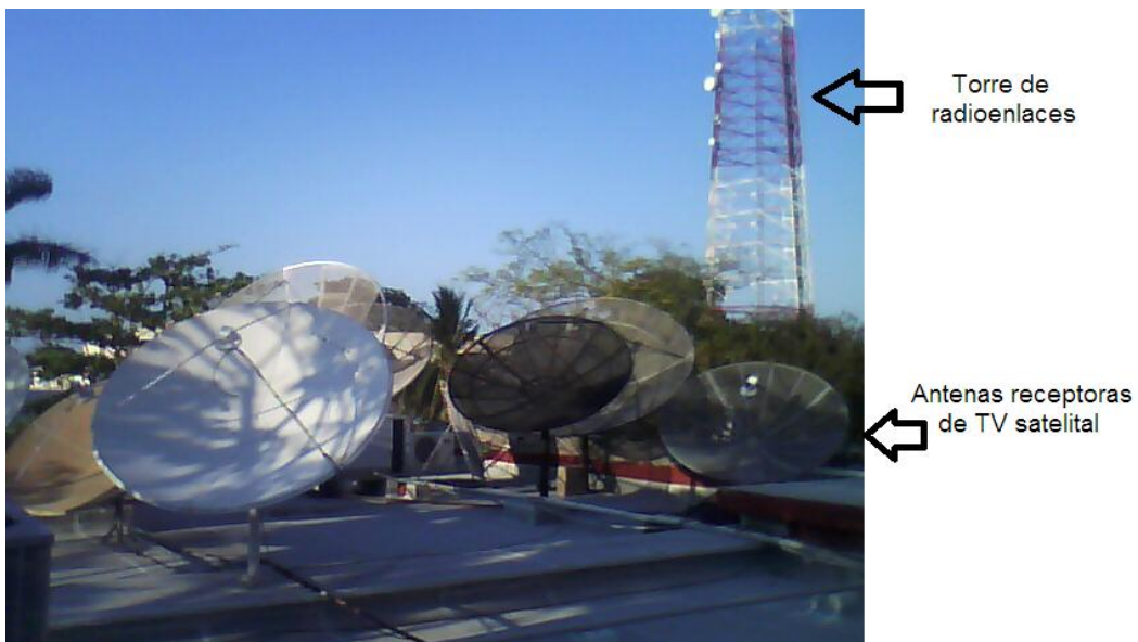
Figura 5.1. Instalación de antenas parabólicas para canal de TV.
