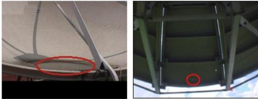
Figura 3.12. Reflector con estancamiento de agua.
