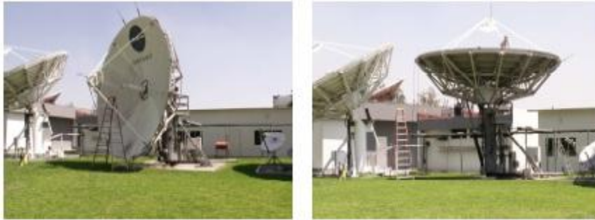
Figura 3.14. Antenas en mantenimiento.
