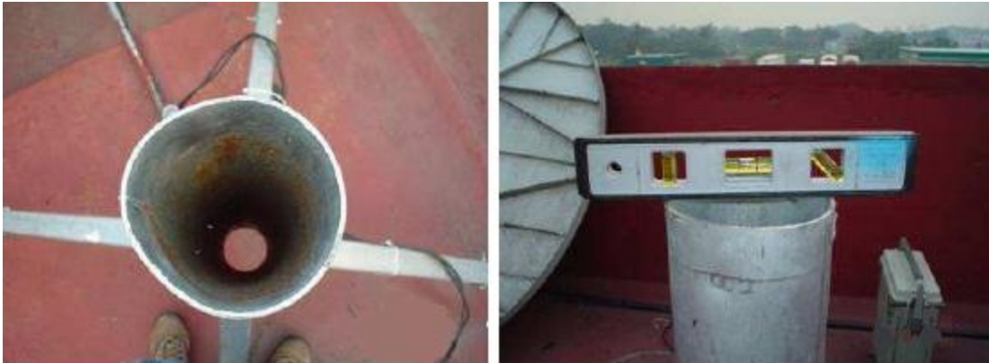
Figura 5.3. Instalación y nivelación del mástil.
