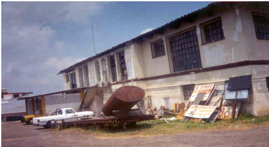
Fachada Posterior con Desperdicio.
