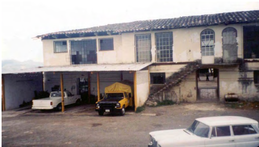
Parte posterior a la fachada principal== localización de taller
