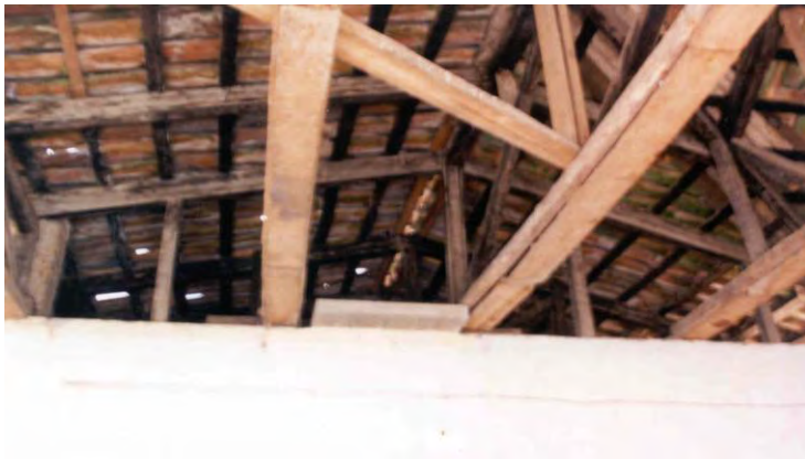
Estructura a base de largueros de madera para techumbre
