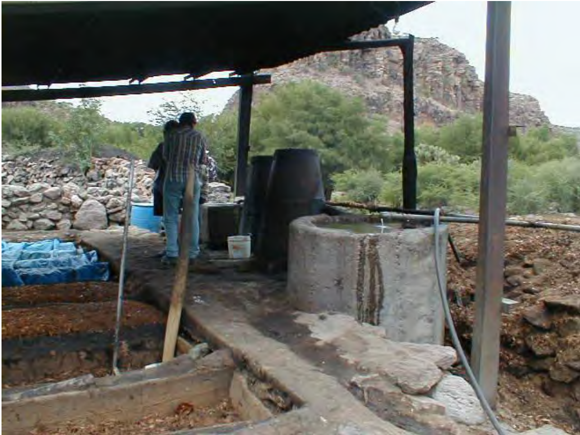
Fig. 121. Pila de piedra recubierta de cemento junto a los alambiques y cajones de machacado y fermentación, son algunos de los componentes que constituyen las instalaciones de la vinata de El Venado del estado de Durango.
