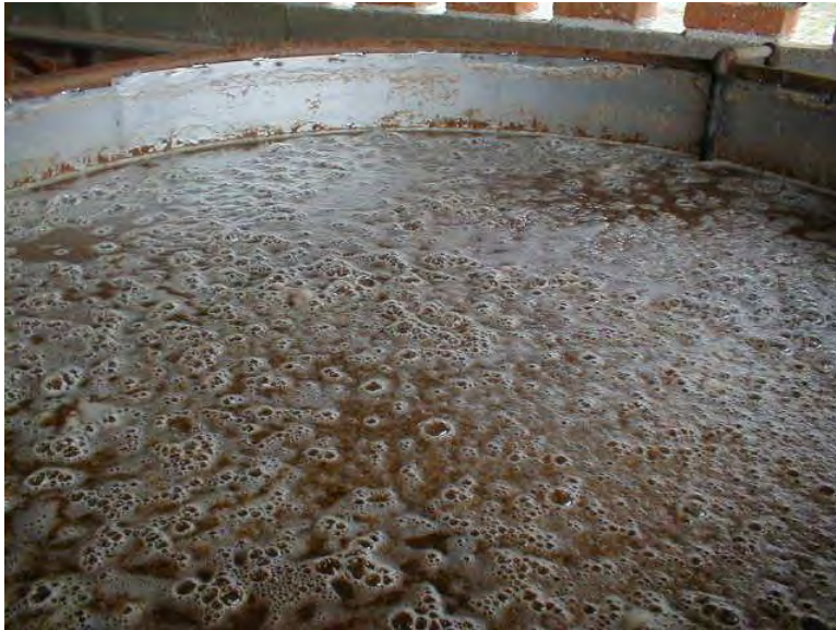
Fig. 103. Con una capacidad de más de 5000 litros, en la fábrica mezcalera de Teul de González Ortega, Zacatecas tienen recipientes cilíndricos de acero para la fermentación.
