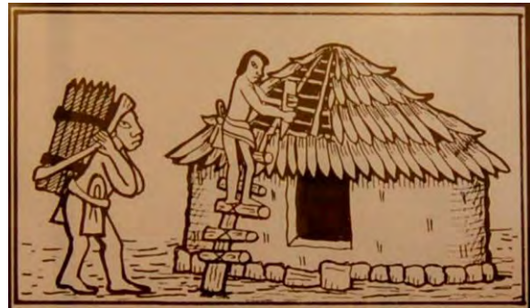
Fig. 76. En algunas poblaciones de Tlaxcala, todavía usan el quite como techo o para los muros de las habitaciones. Recreación de techumbre con quiotes y pencas. Tequilera La Cofradía, Tequila, Jalisco.
