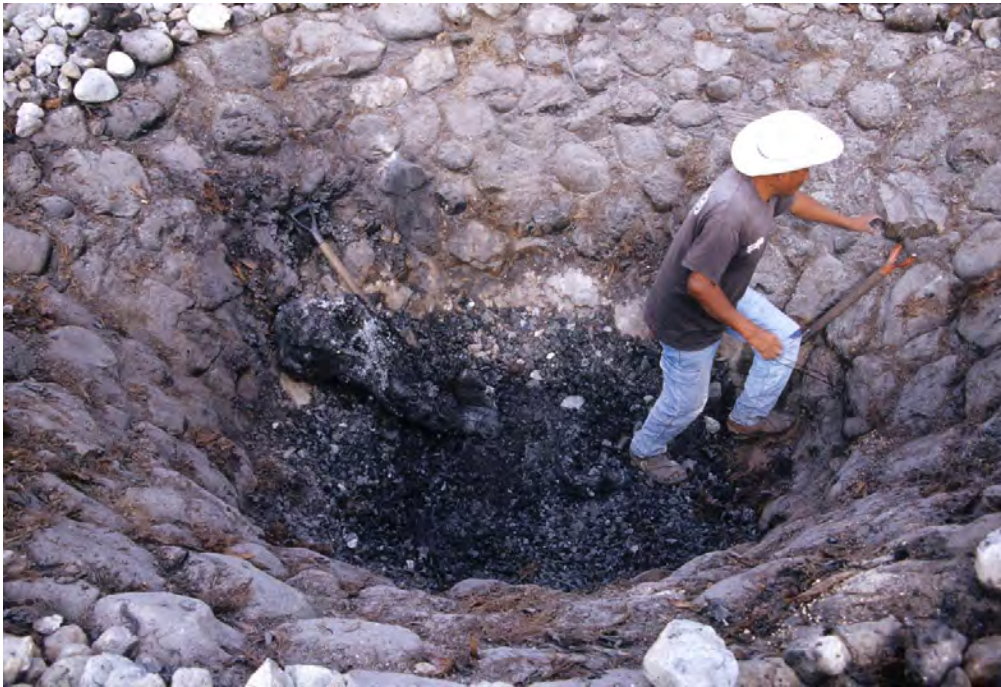
Fig. 24. Diversos hornos de grandes dimensiones (3.50 m de diámetro) con paredes de piedra se utilizan todavía en la comunidad de Santiago Matatlán.
