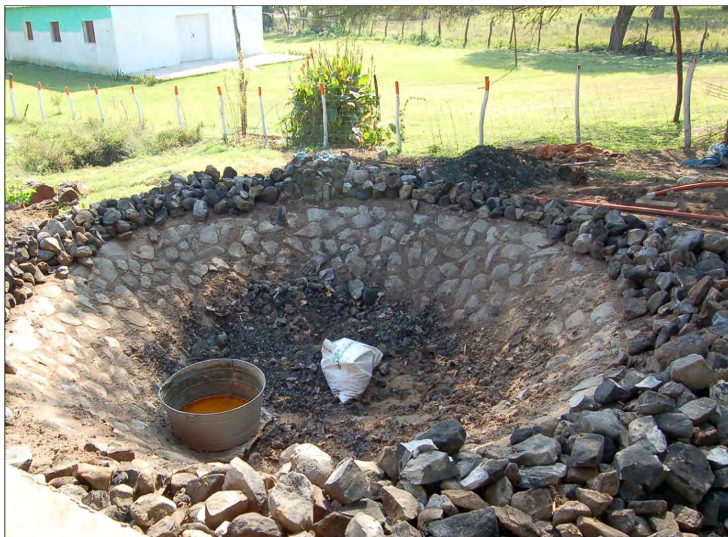
Fig. 85. Horno con paredes de piedra. Comunidad de San Carlos, estado de Tamaulipas.
