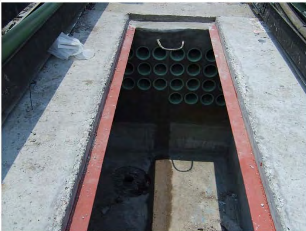
Figura III.31 Emboquillado en registros
