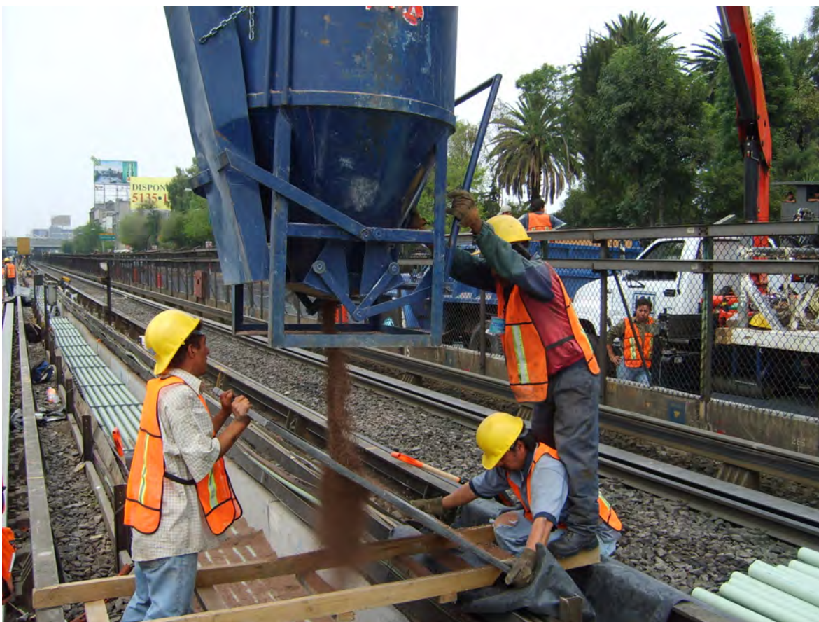
Figura III.27 Descarga de arena sobre banco de ductos
