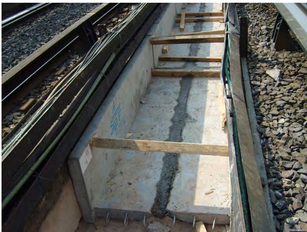
Figura III.24 Junteo de prefabricados.
