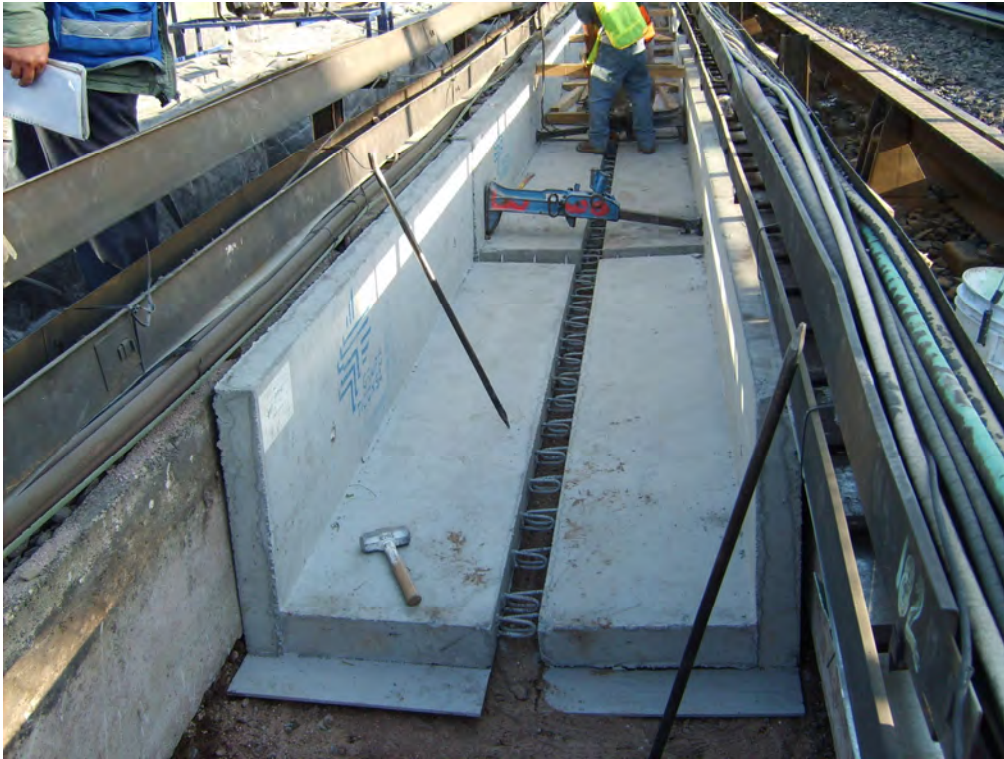
Figura III.21 Separación de prefabricados con gatos mecánicos y apuntalamiento de los mismos.
