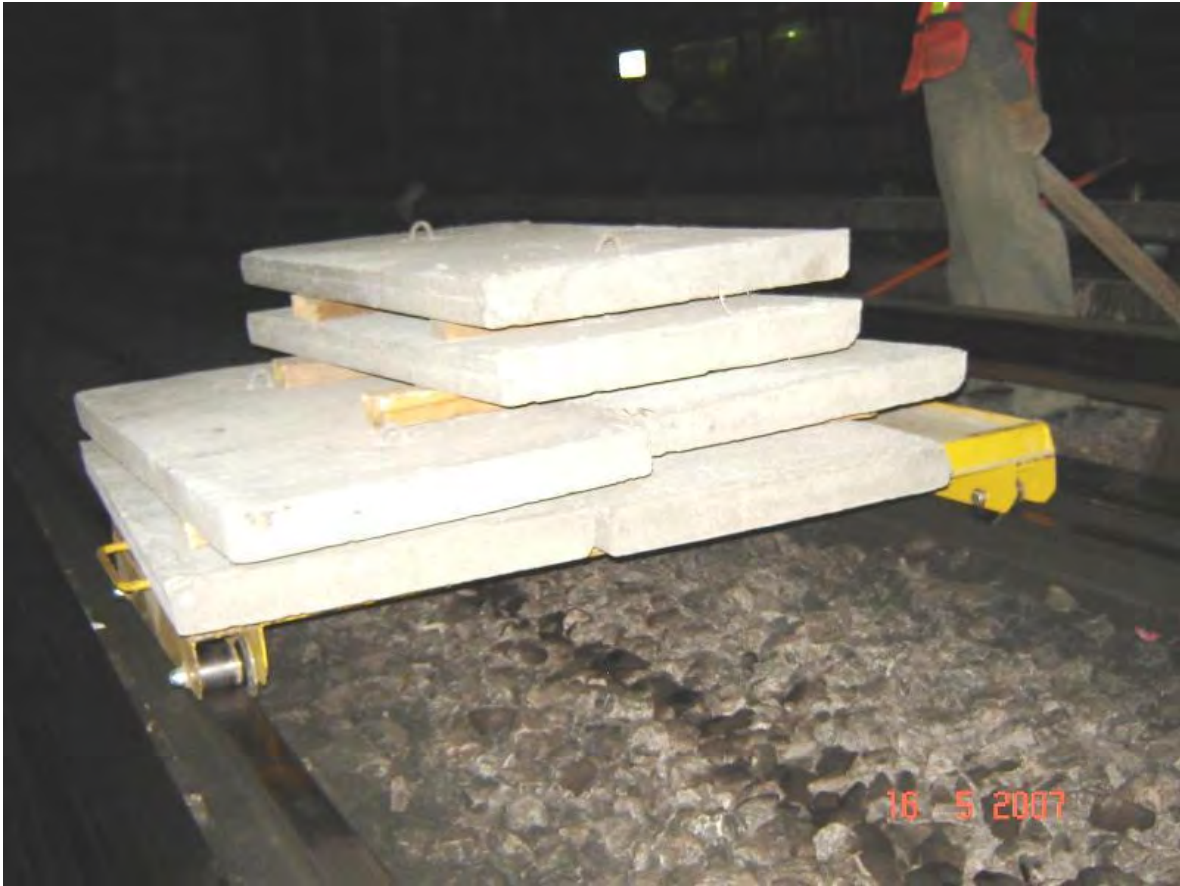
Figura III.33 Tapas de concreto reforzado.
