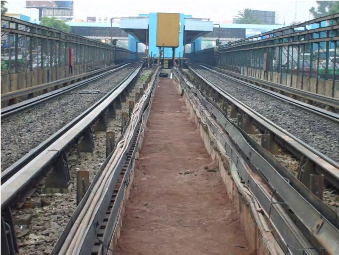
Figura III.16 Colocación de cama de arena.
