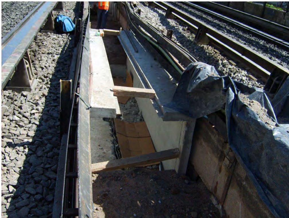
Figura III.22 Apuntalamiento de un prefabricado tipo registro.
