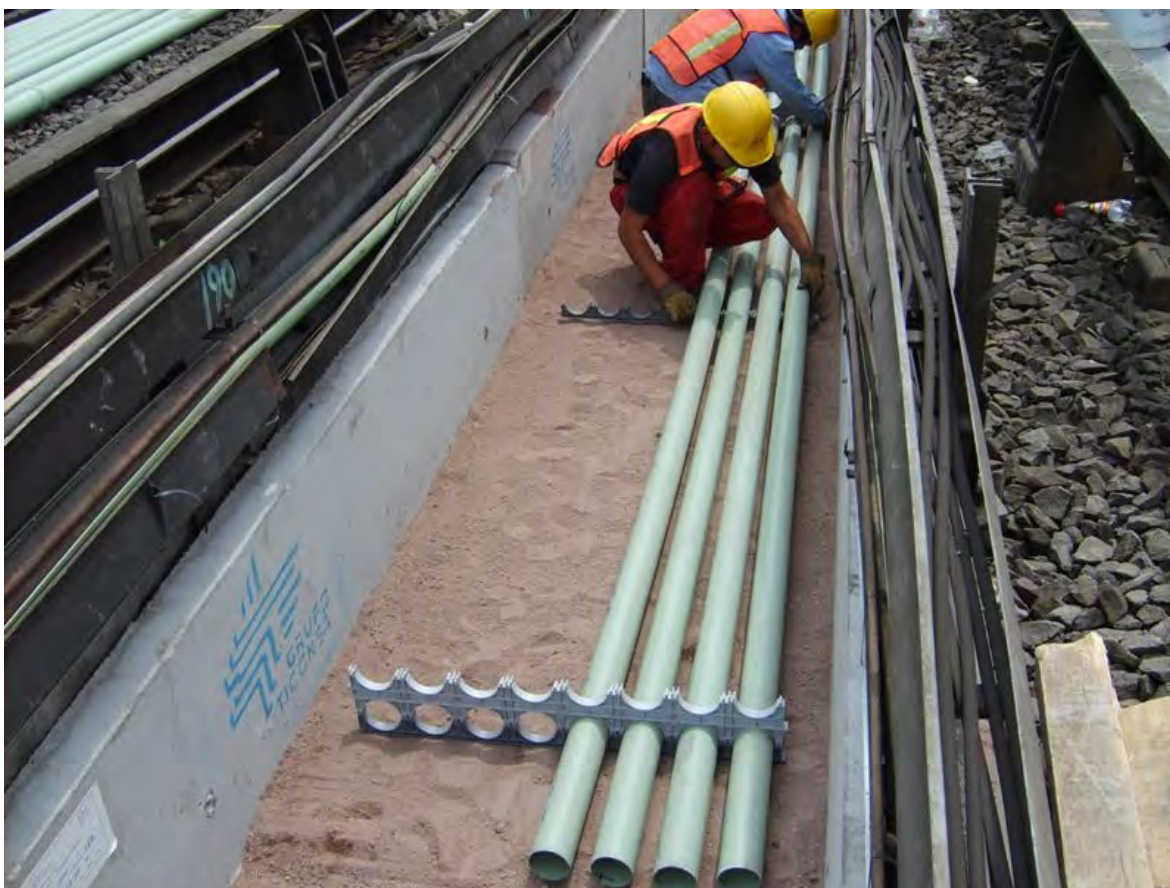
Figura III.26 Colocación de ductos dentro de los prefabricados de concreto.
