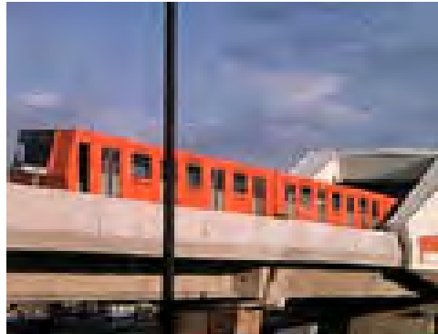
Figura I.2 Línea 4 construida en la segunda etapa de construcción del metro.
