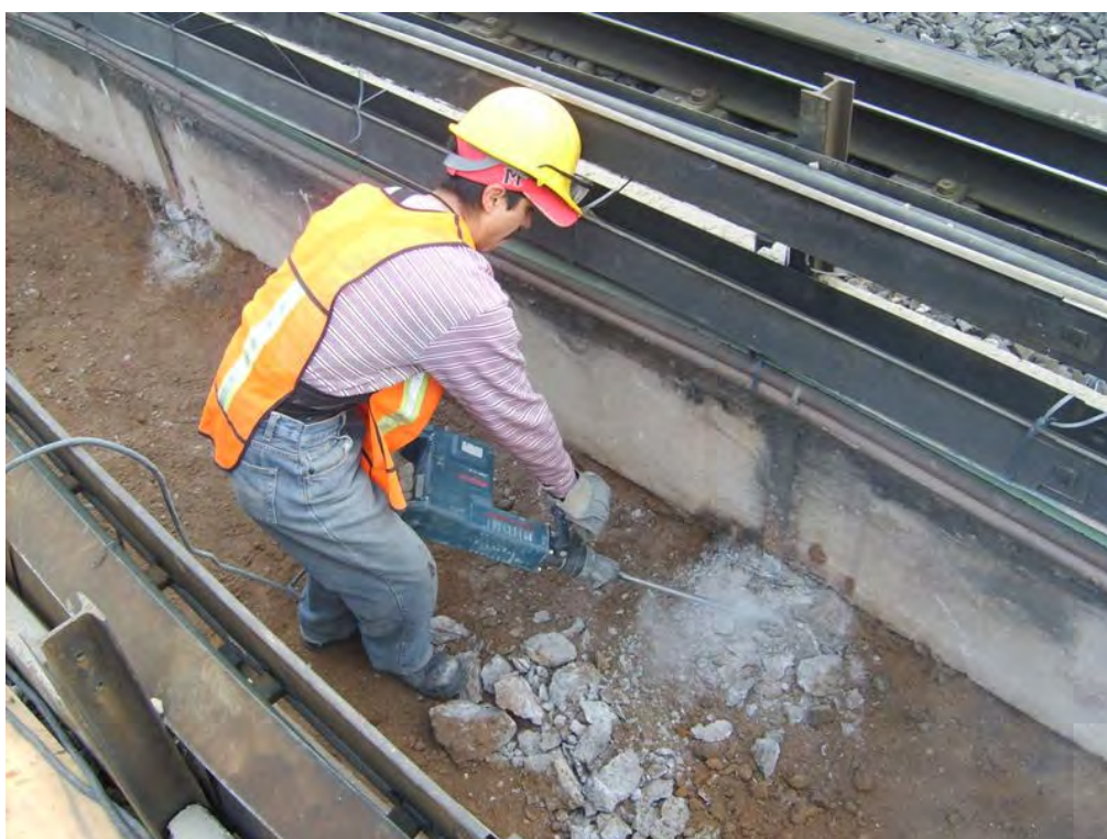
Figura III.15 Demolición de dados de concreto existentes como cimentación de postes soporte.
