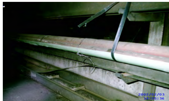
Figura III.2 Colganteo de cables de 23 kv.
