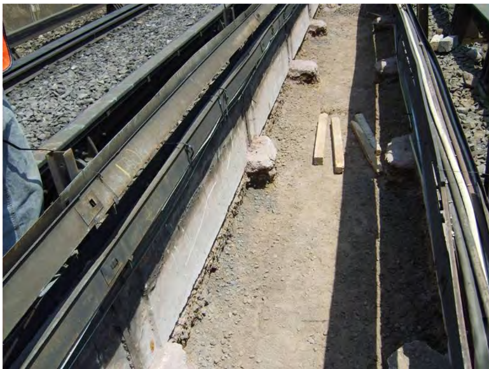
Figura III.14 Vista de andador central, dados de concreto a demoler.
