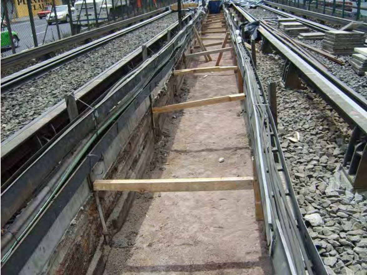
Figura III.12 Apuntalamiento de paredes de excavación.
