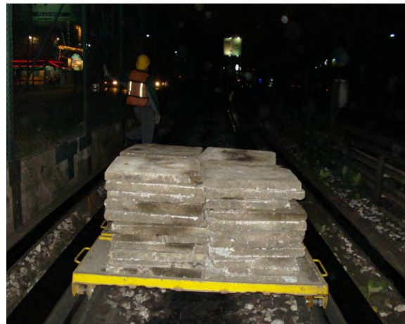
Figura III.4 Estiba de placas de concreto reforzado en lorry para su retiro.
