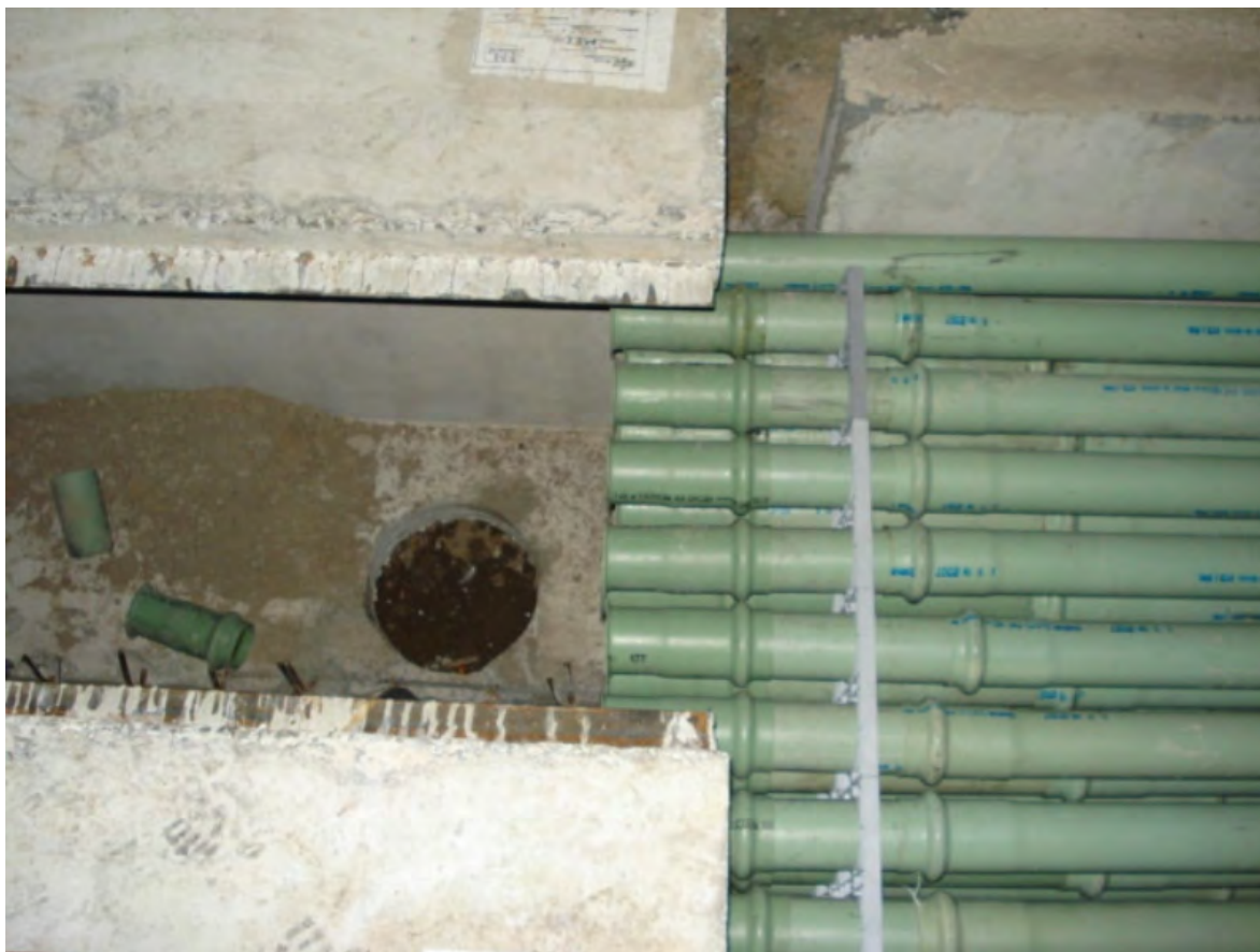
Figura III.30 Preparaciones para emboquillado en registros
