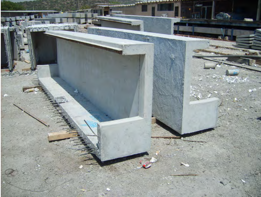
Figura III.18 Patios de fabricación, prefabricados tipo registro.
