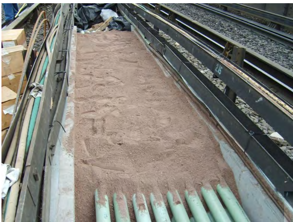
Figura III.29 Arena sobre banco de ductos
