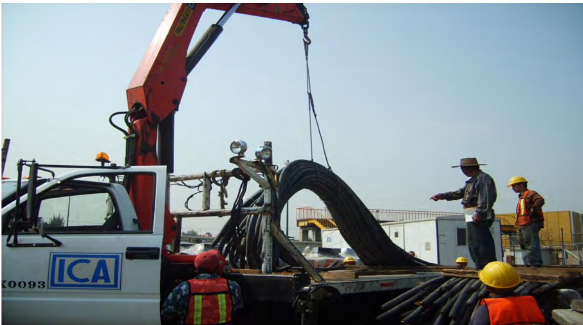
Figura III.7 Retiro de cable tripolar en secciones de ocho metros.
