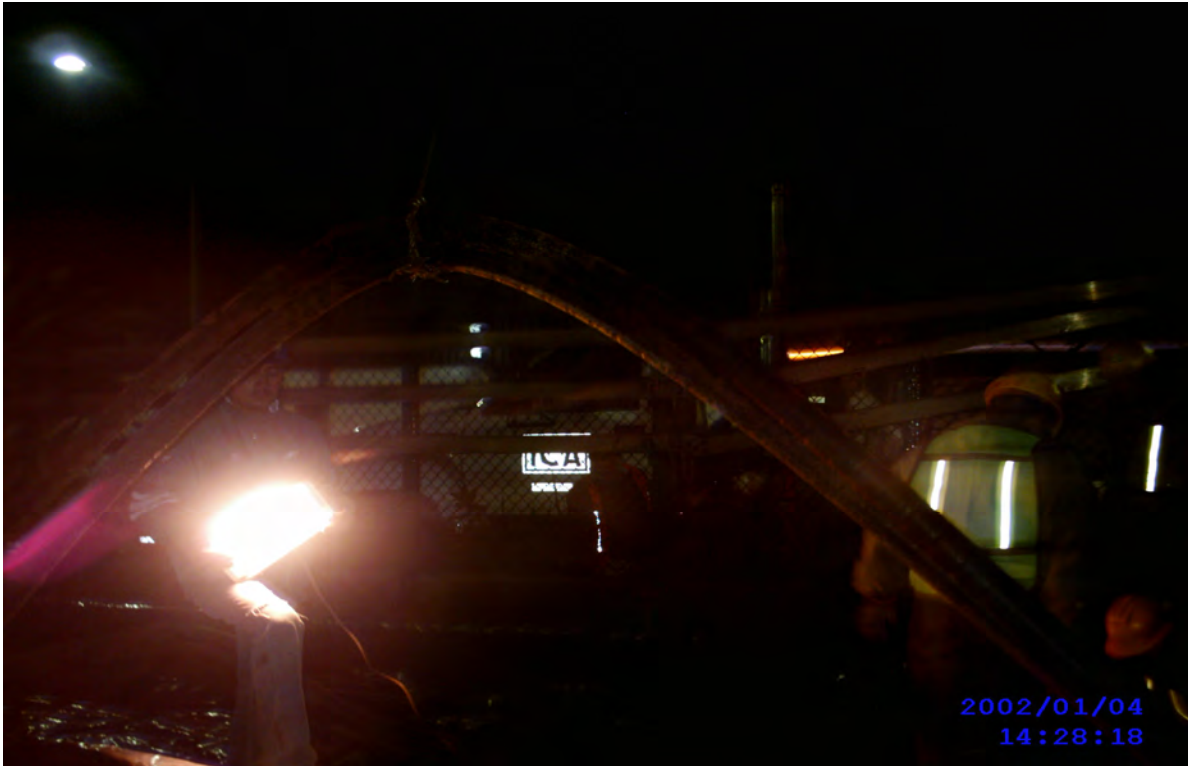
Figura III.7 Retiro de cable tripolar en secciones de ocho metros.
