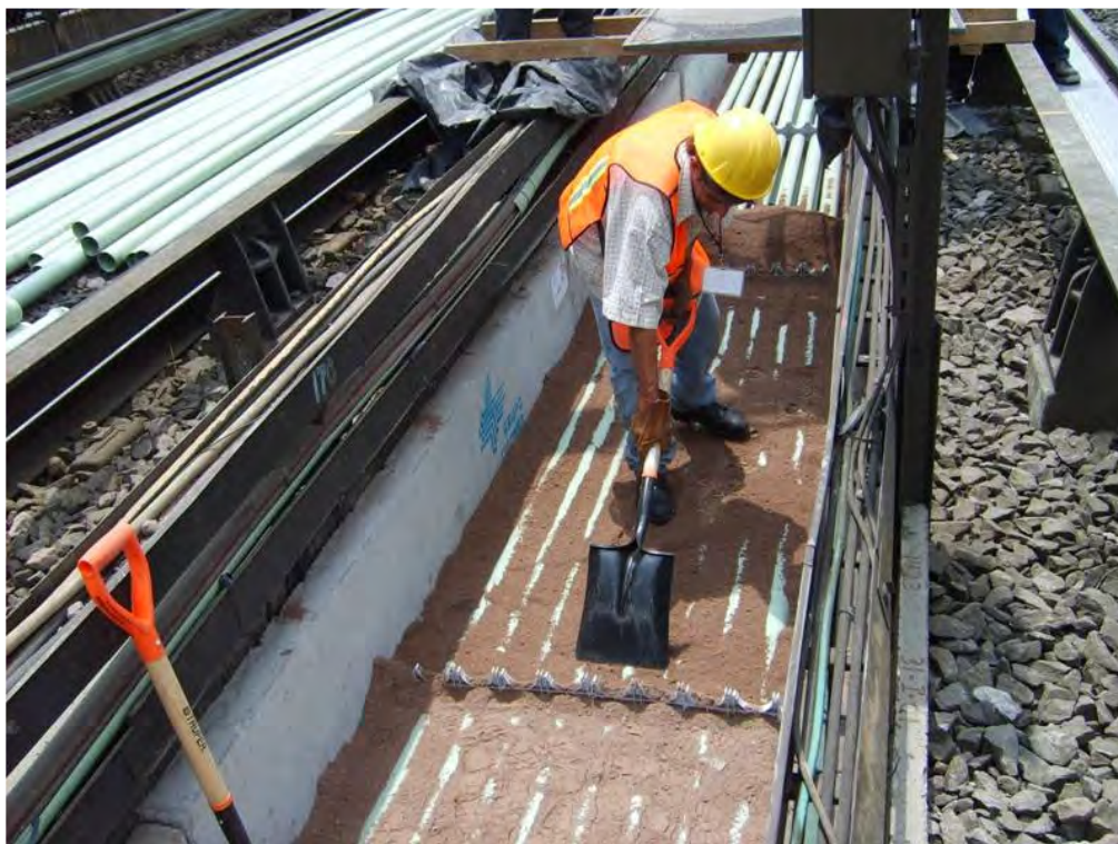
Figura III.28 Distribución de arena sobre banco de ductos
