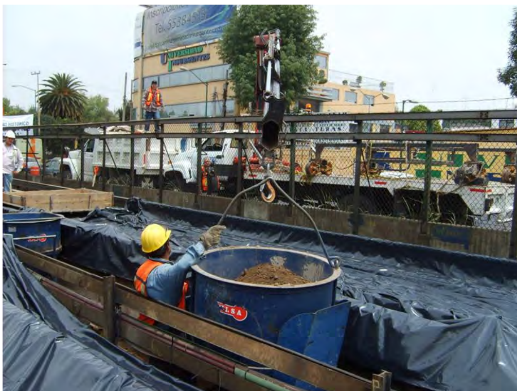
Figura III.11 Retiro de excavación superficial.
