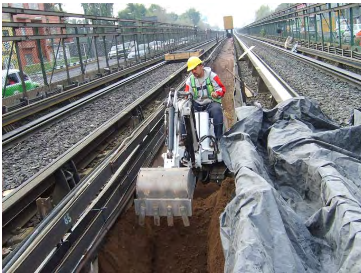
Figura III.9 Excavación superficial por método mecánico.
