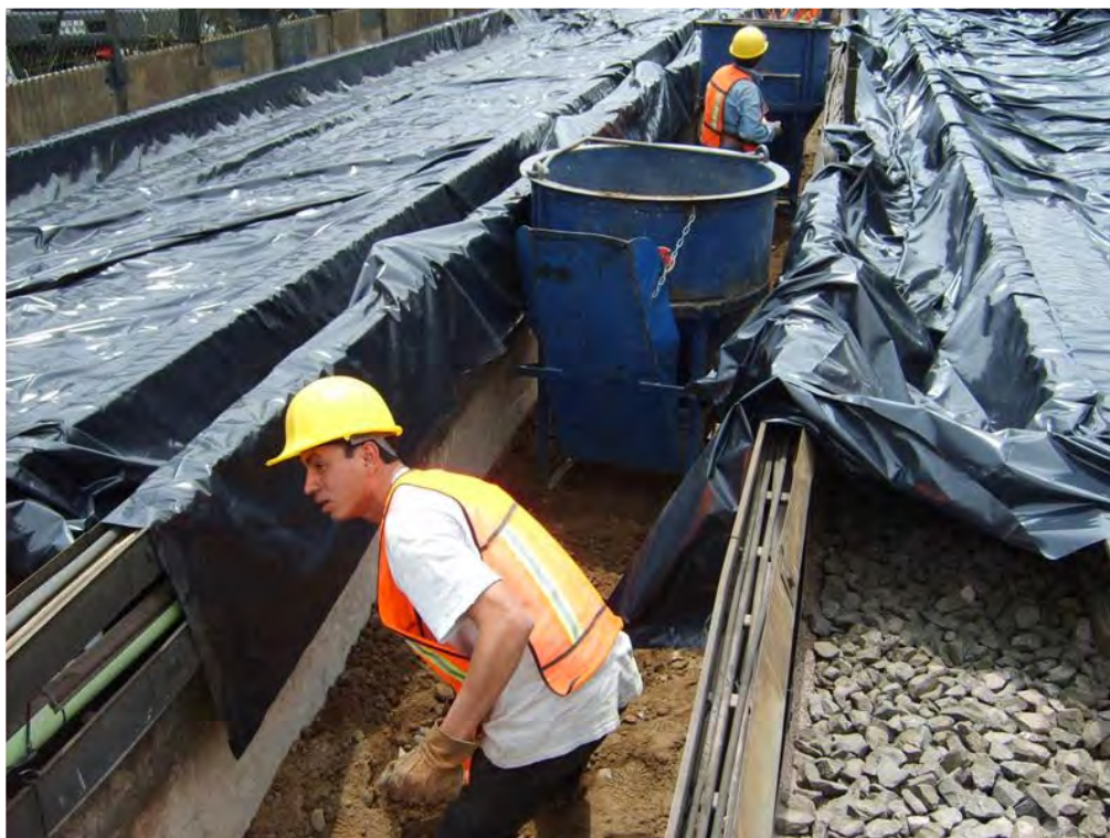
Figura III.10 Excavación superficial por método manual.
