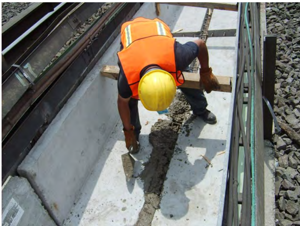
Figura III.24 Junteo de prefabricados.
