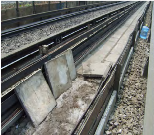
Figura III.3 Estado original de las losetas de concreto reforzado sobre el andador central.
