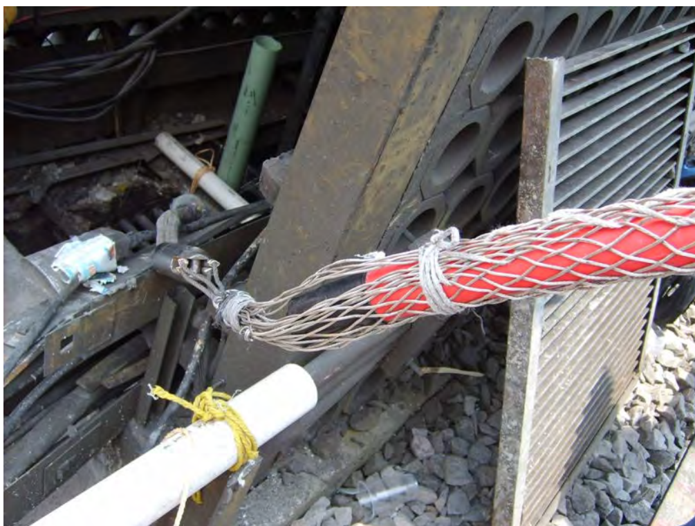
Figura III.37 Cobra para jalado de cable.
