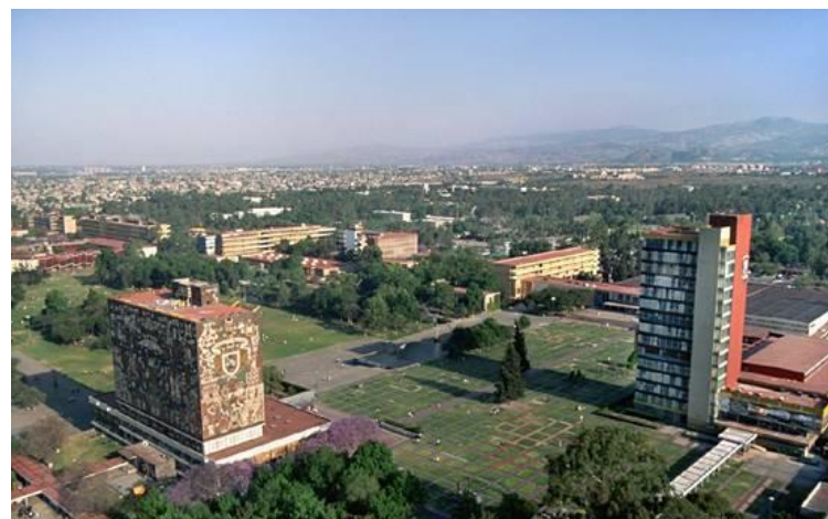
Vista aérea actual del conjunto
