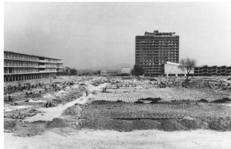
Avance de obra de CU en 1952
