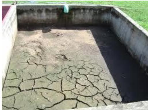
Figura 3.1.- Lodo residual, planta de tratamiento.
