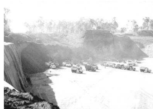
Ilustración 8: Relleno Sanitario en Prado de la Montaña
