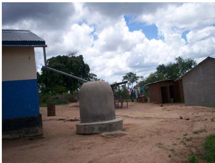
Figura 35. Pequeño sistema de captación de aguas pluviales en una escuela primaria en la Villa de Maasai, África
