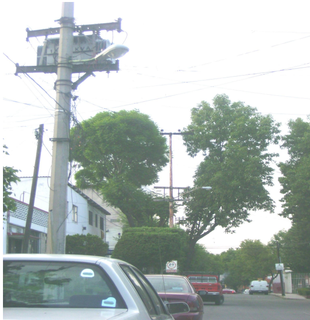
Figura 15.- Copa desbalanceada a causa de una poda mal realizada para liberar cables de conducción de energía eléctrica.
