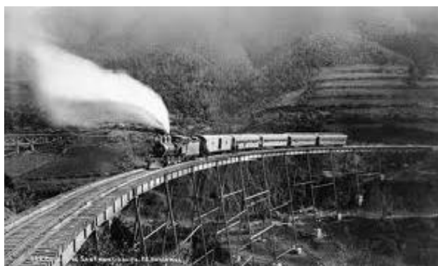
Puente de San Francisquito en el Ferrocarril Nacional.
