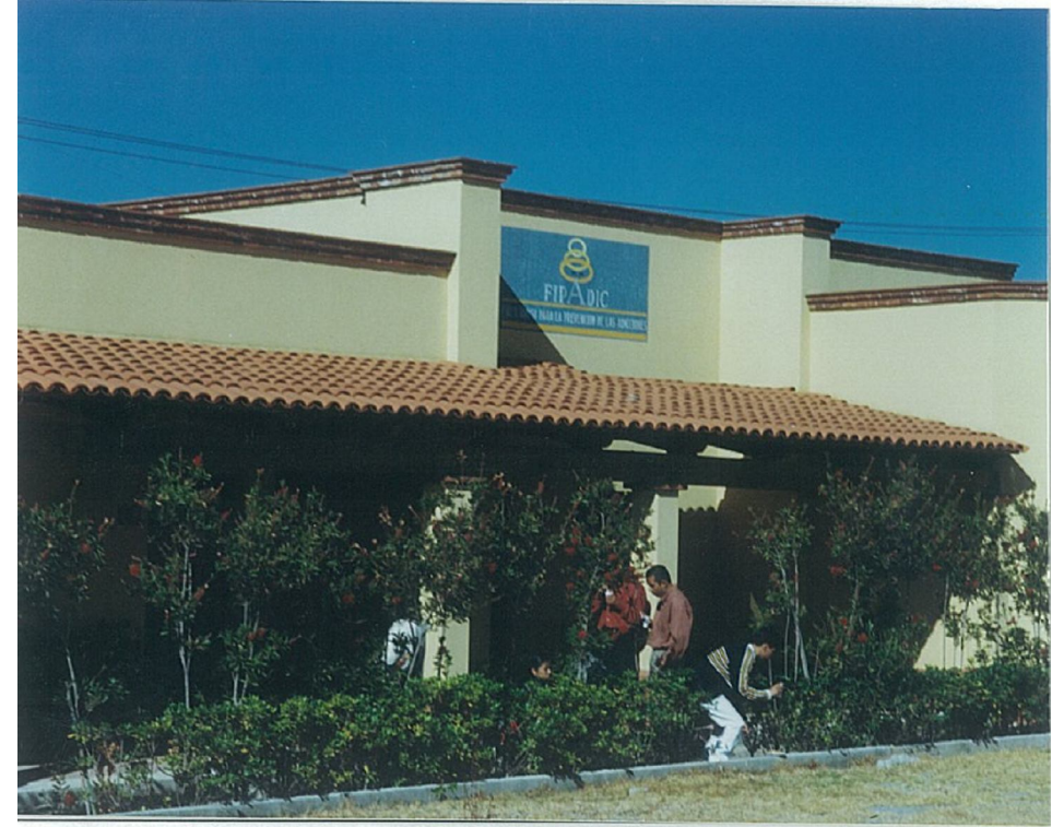
Vista exterior sala de usos múltiples foto núm. 2
