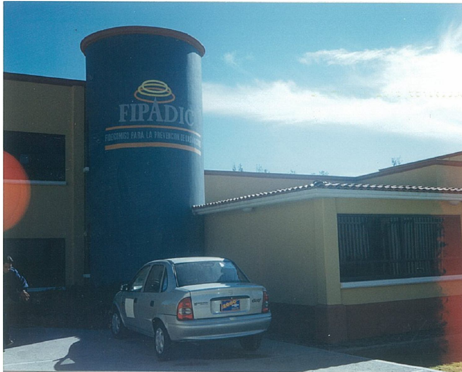
Vista General área administrativa foto núm. 1
