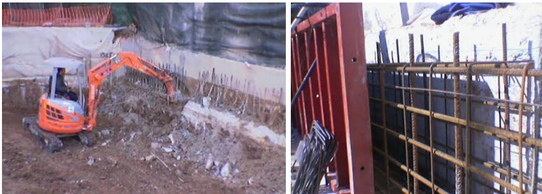
Figura 21. Trabe de coronamiento
