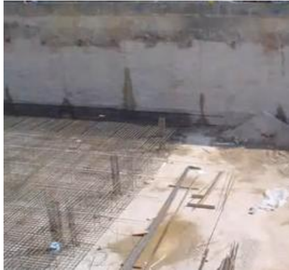
Figura 25. Armado para losa de fondo
