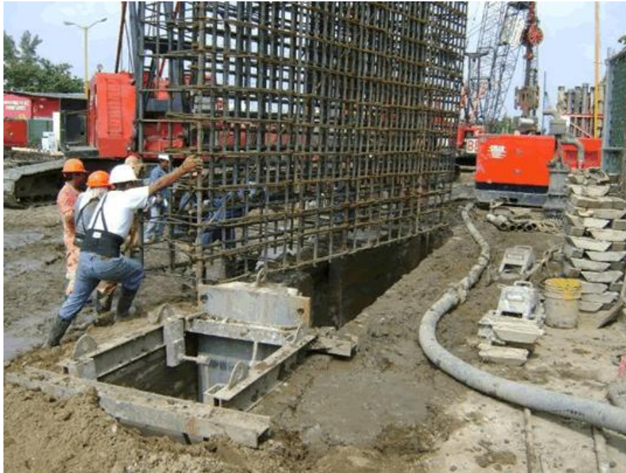
Figura 18. Armado de acero para un panel de la lumbrera
