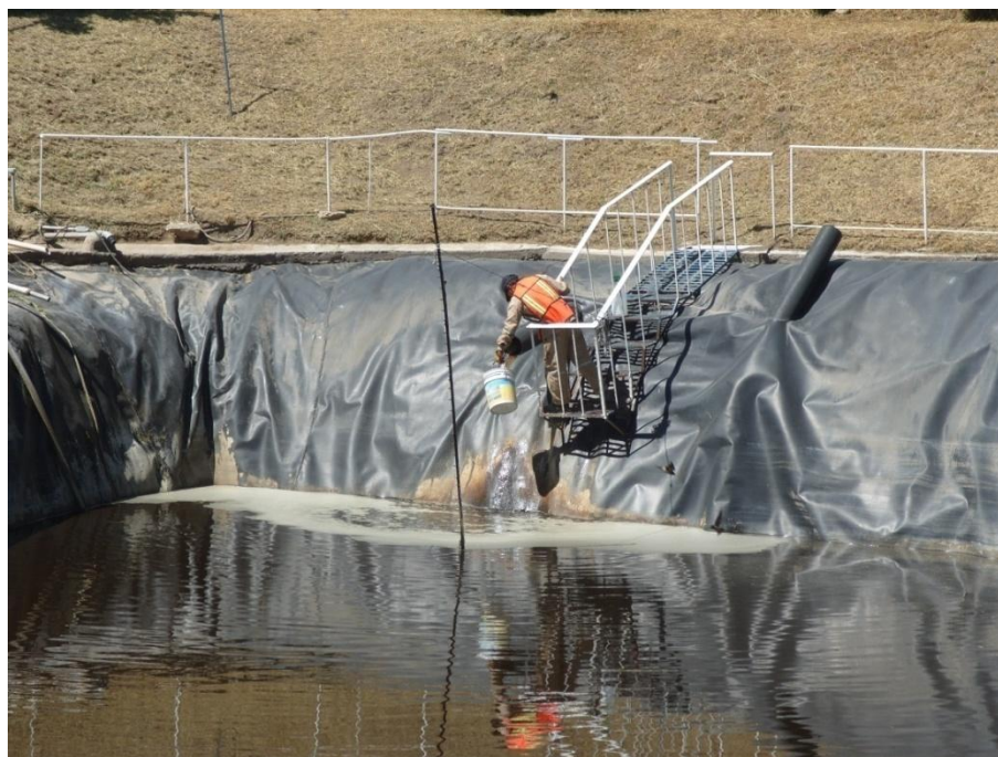
Fotografía 1. Muestreo de los lixiviado en el relleno sanitario de Tlalnepantla de Baz, Edo.de México.
