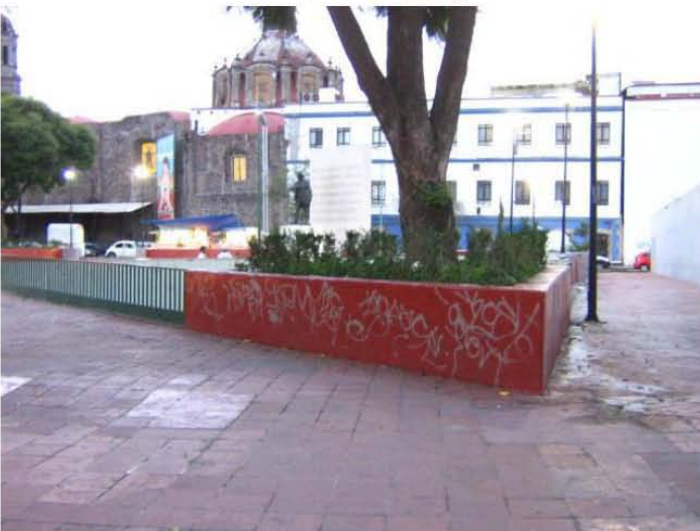
En la jardineras existen arboles de aprox. 8mts. de altura
