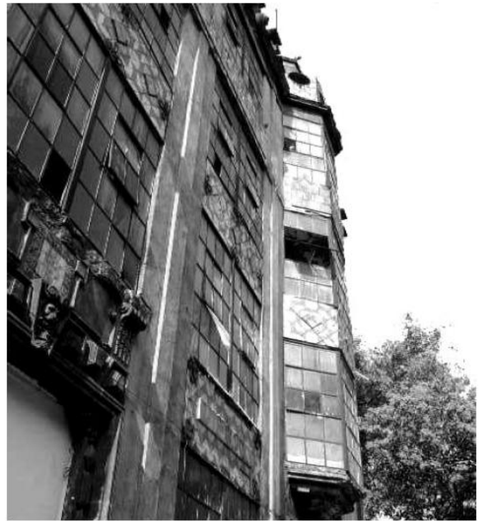
Fachada Talleres Tostado, Federico Mariscal.
