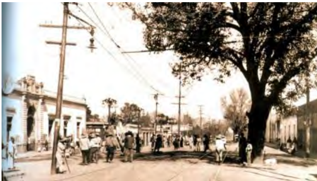
Figura 14 - 1922 - Av. Mixcoac hoy Av. Revolución mostrando la cárcel local. Es posible ver los primeros postes eléctricos en la zona.
