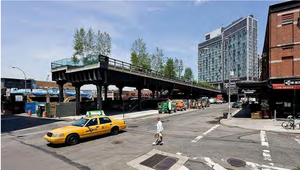
Figura 36 - La intervención se extiende reciclando infraestructura preexistente uniendo diversos distritos.
