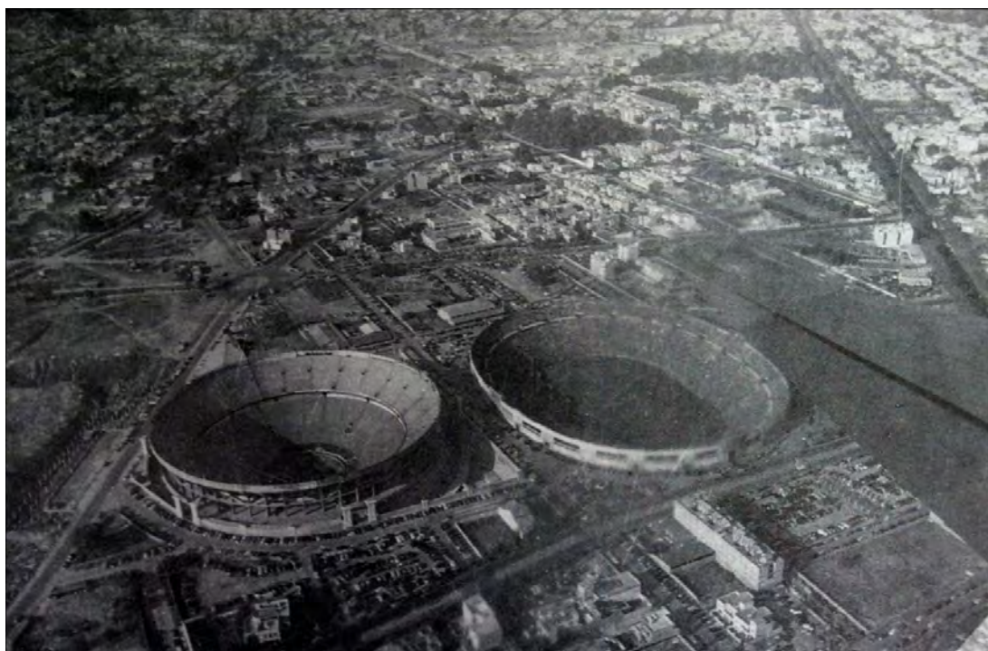
Figura 23 - Aquí se proyecta la Ciudad de los Deportes: la Plaza de Toros México y el actual estadio del Cruz Azul, 1950.
