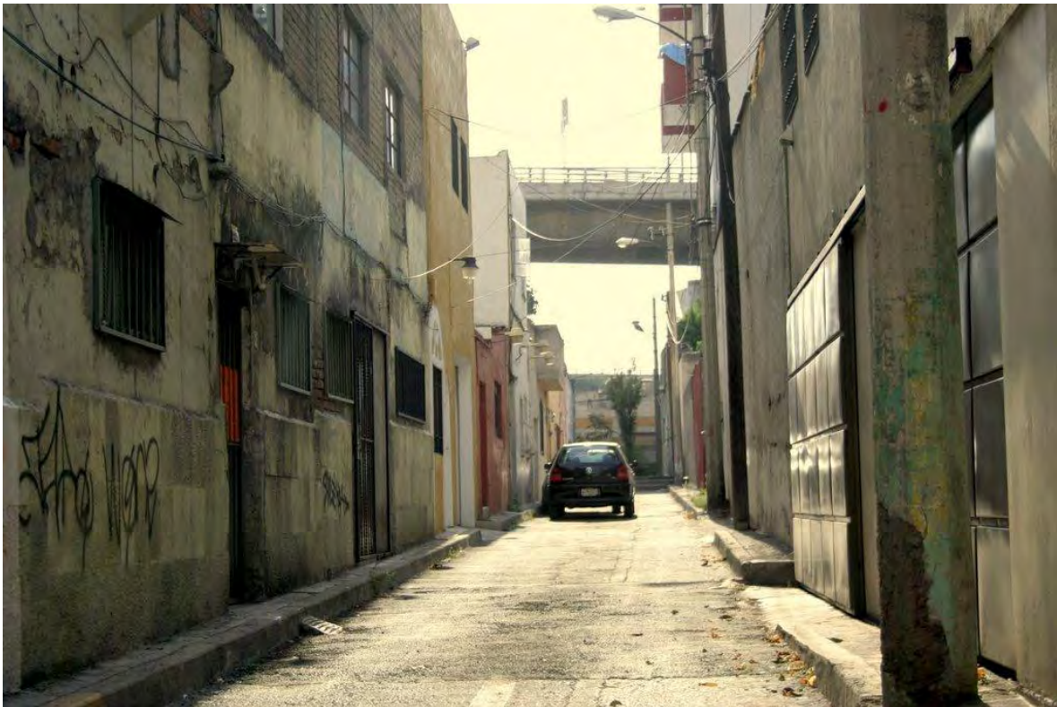
Figura 30 - La falta de apropiación vecinal promueve el deterioro de la imagen urbana.
