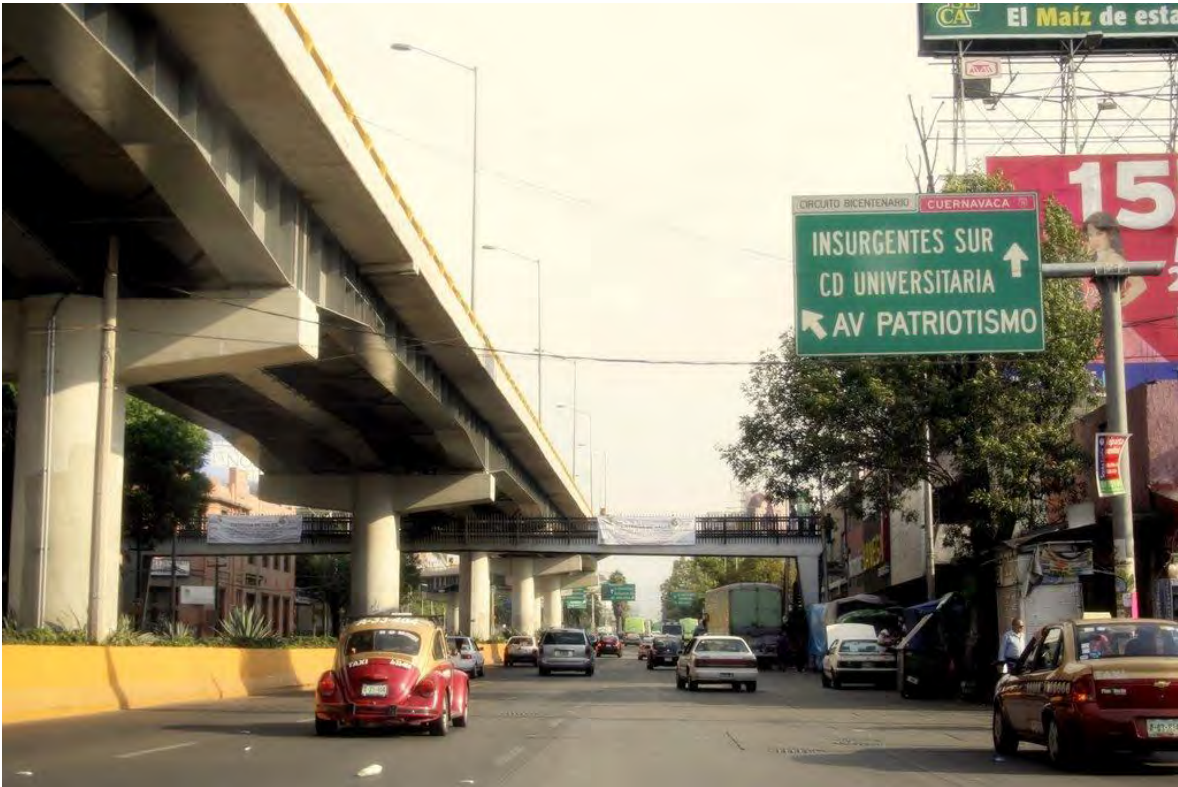
Figura 32 - Av. Revolución. Es notorio el número cada vez mayor de obras viales que se llevan a cabo, mismas que lejos de remediar el creciente tránsito vehicular, representan barreras físicas y visuales dentro de Mixcoac.
