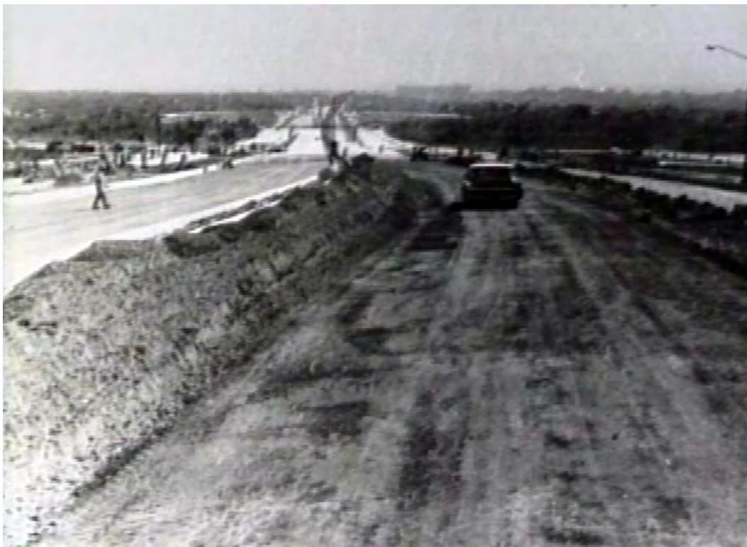
Figura 26 - Construcción del Anillo Periférico en 1968.
