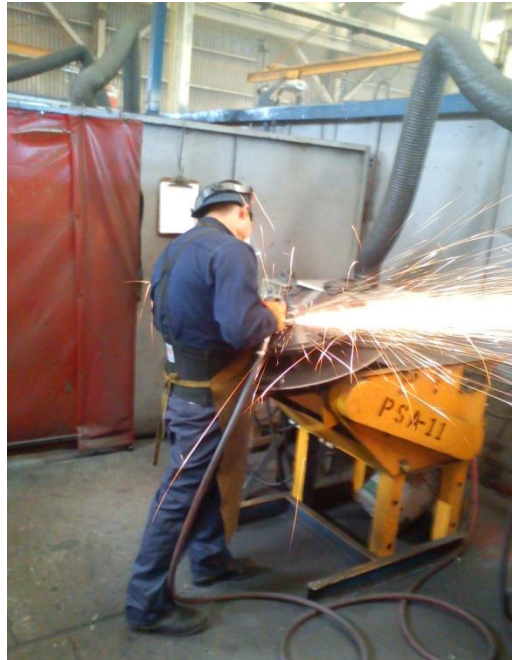
fig.26 Esmerilado de los cordones de soldadura de las aspas.
