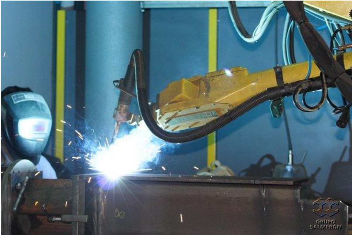
fig.33 Proceso de soldadura automatizado.
