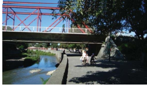
2. Puente que liga a la carretera con la ciudad.
