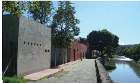
5. Zona más consolidada del corredor, con construcciones en buenas condiciones.
