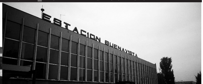
IMAGEN 6_ ESTACIÓN BUENAVISTA. TREN SUBURBANO.
