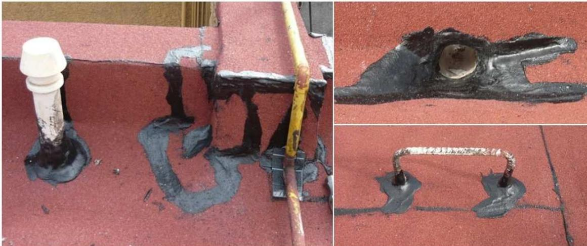
**Fotografía 2.** Detalles de las uniones de la membrana impermeabilizante, y sellado en bajas pluviales y en elementos existentes en la cubierta para evitar el paso de humedad a la cubierta. Fuente: Archivo GARCÍA, Ilse, México, 2010.
