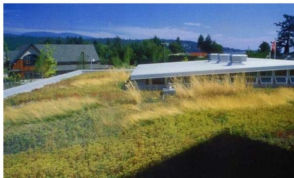
**Imagen 10.** Vista de la cubierta con un sistema de naturación extensivo del edificio del Centro de servicios de Justicia Sechelt, en Sechelt, Canadá. Fuente: Earth Pledge, "Green Roofs. Ecological design and construction", Schiffer, 2005, pág. 36.
