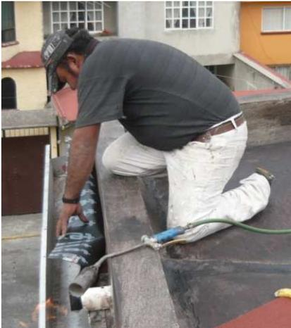
**Fotografía 1.** Colocación de la membrana impermeabilizante a base de una película asfáltica, colocada por termofusión. Fuente: Archivo GARCÍA, Ilse, México, 2010.
