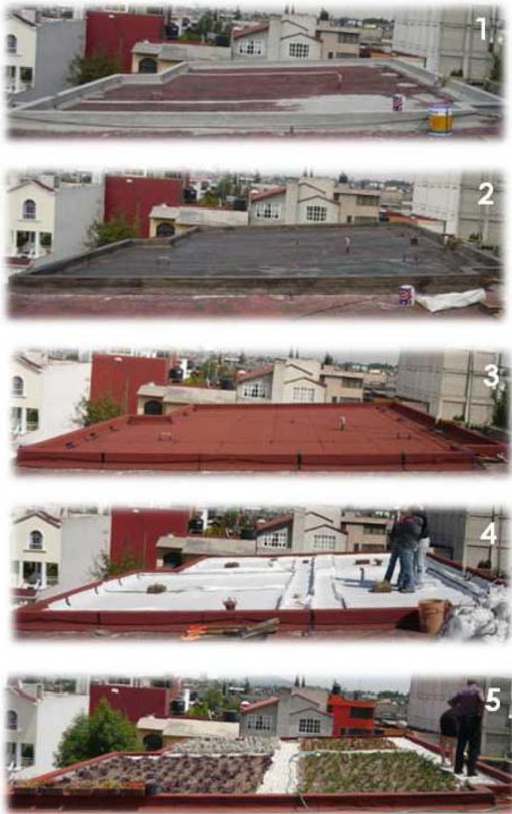
Imagen 51. Proceso de instalación de la cubierta naturada. Fuente: Archivo GARCÍA, Ilse, México 2010.
