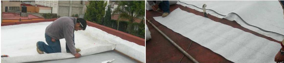
**Fotografía 3.** Colocación del geocompuesto, que cumple la función drenante y filtrante a la vez.
