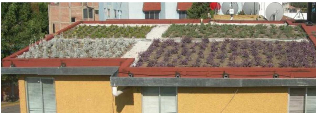
**Imagen 53.** Vista de la cubierta naturada. Fuente: ORTEGA, "Diseño del modelo paramétrico para evaluar el desempeño térmico de una cubierta verde", Artículo SNES2010-ABC-038, México 2010.
