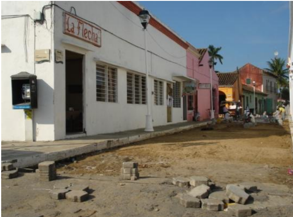
Imagen 11 - Reparaciones necesarias hechas en el adoquinado de las calles. En el malecón frente al Restaurante La Flecha. Noviembre 2010.
