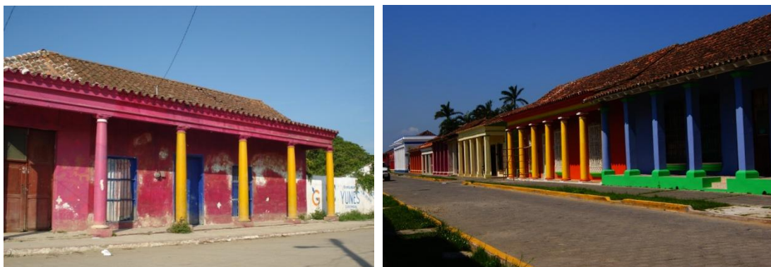
Imagen 12 – Contraste en la imagen de las fachadas de las casas de Tlacotalpan; en la primera fotografía se ve una casa con la fachada sin pintar, todavía afectada por la humedad, mientras que en la segunda se pueden ver las fachadas recién pintadas y perfectamente compuestas de otras casas más céntricas. Noviembre 2010.
