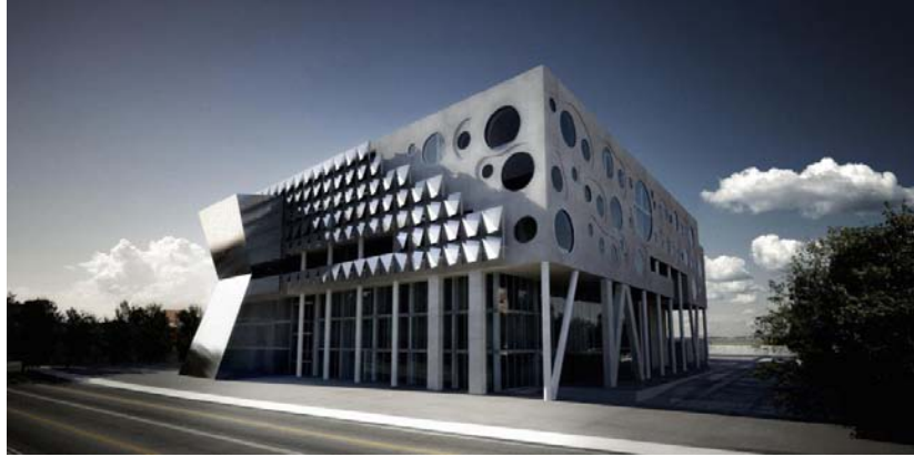
Foto: Fachada trasera, vista desde la carretera.
