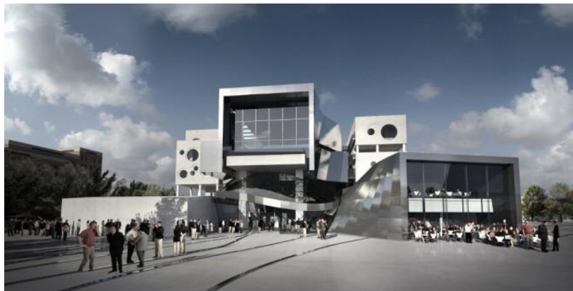
Foto: Vista de la Fachada principal y el acceso.
