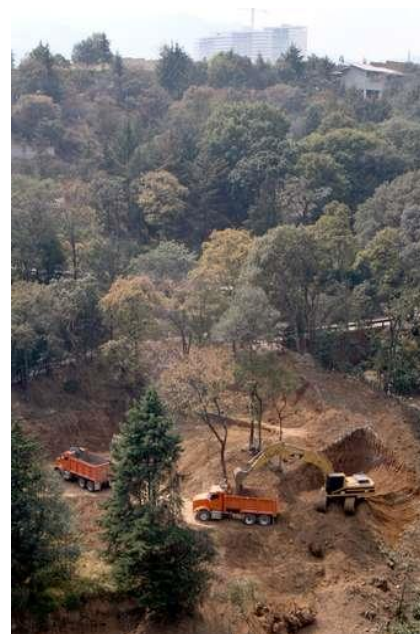
Imagen: Trabajos Preliminares del Suelo en la Zona de Santa Fe
