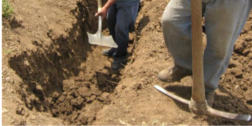
Foto: Excavación para drenaje
