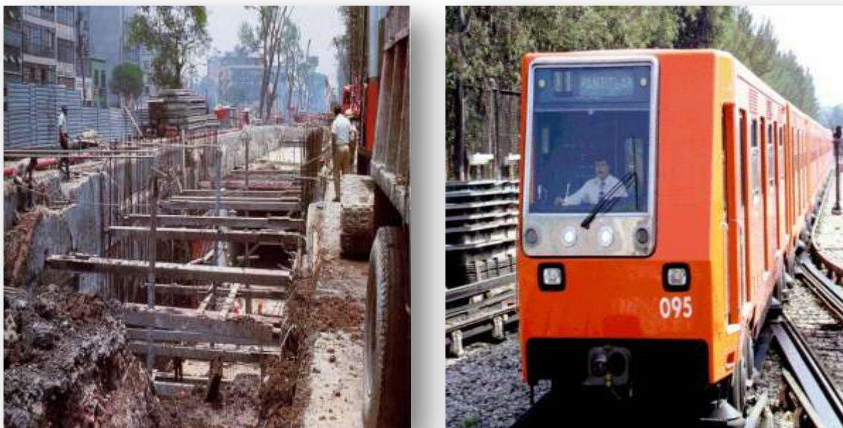
Figuras 1.5, 1.6 Construcción del cajón subterráneo (izquierda), Material rodante neumático (derecha).
