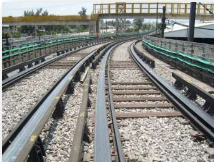
Figura 1.7 Vías, cola de maniobras Pantitlán línea 9.
