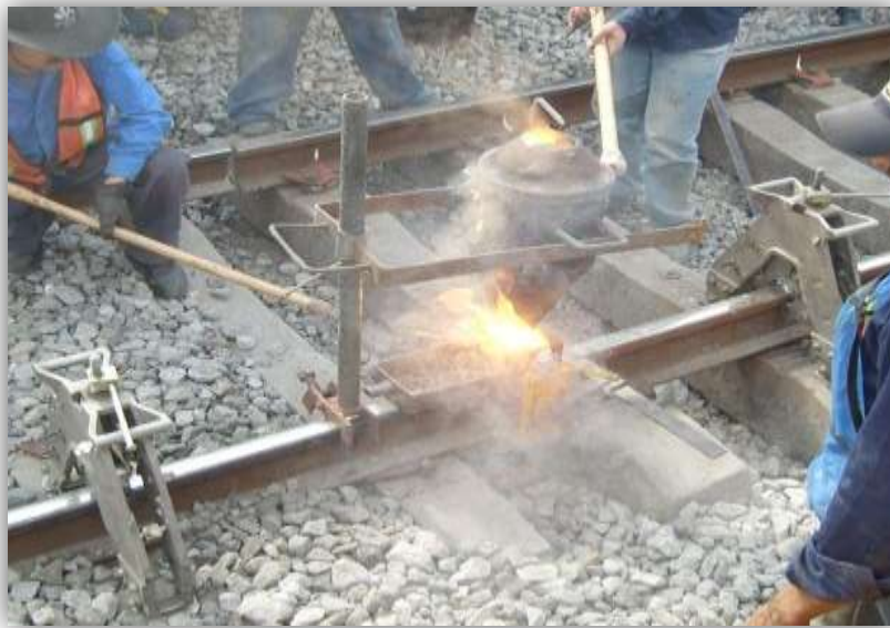
Figura2.12 Soldadura aluminotérmica.
