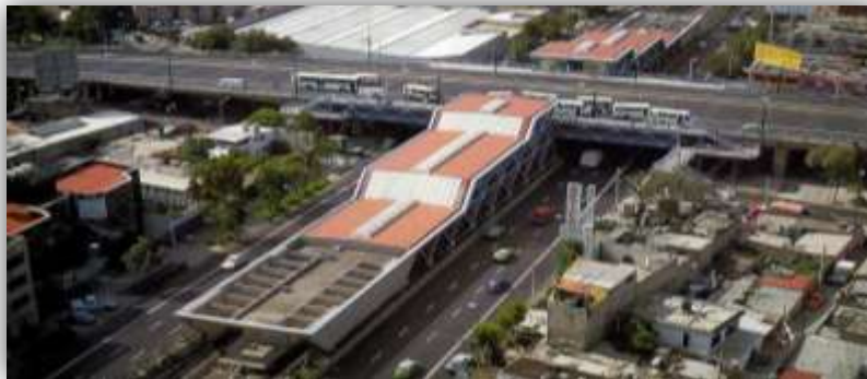
Figura2.6 Estación Coyuya línea 8 tipo superficial.
