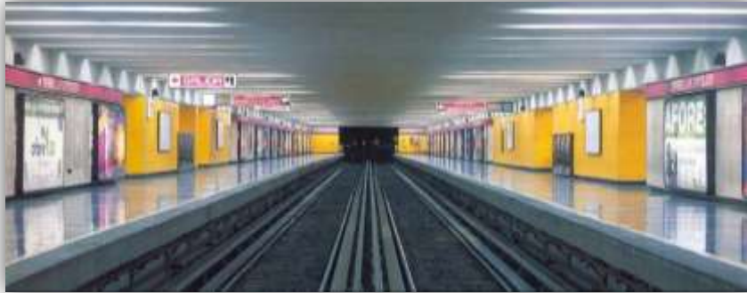
Figura 2.5 Estación I. la Católica línea 1 tipo subterránea.
