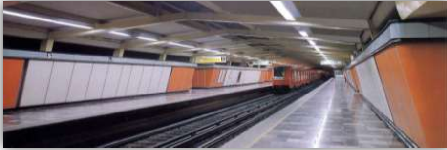
Figura 2.8 Estación con dos andenes laterales.
