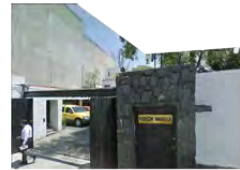
Edificio Sección Amarilla
