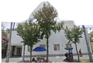
Edificio SEP_ banco Serfin
