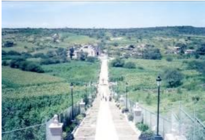
Figura 3.11. Santa Ana de Guadalupe: Calzada de los Mártires.
