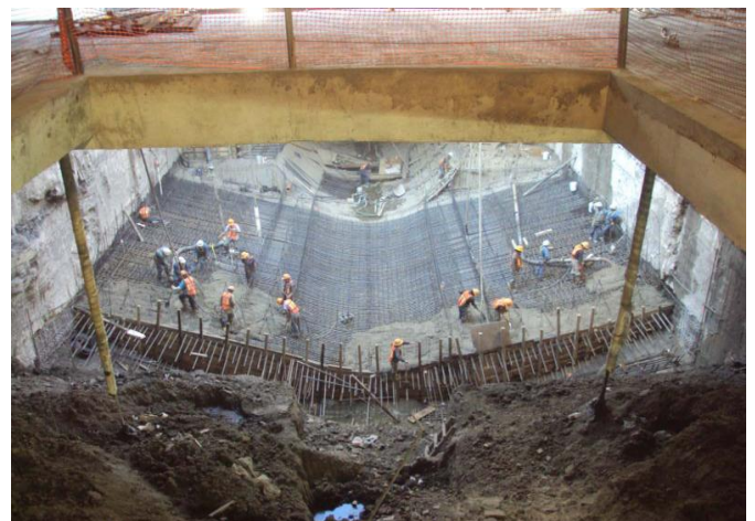
b) Colado de losa de fondo
