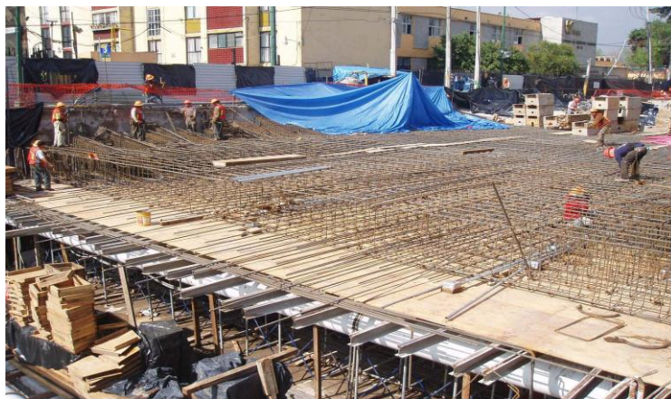
Figura 3.5. Preparación y colado de la losa tapa
