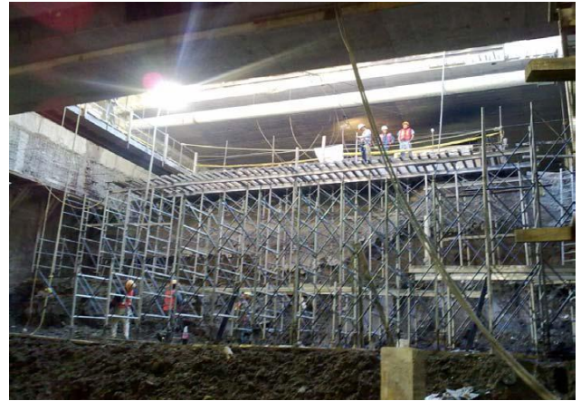
a) Armado y colado de losa mezzanine
