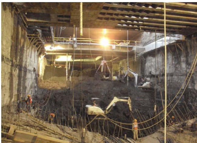
a) Excavación de losa de fondo
