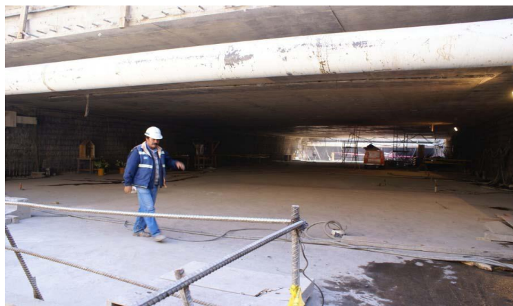
b) Losa de mezzanine terminada
