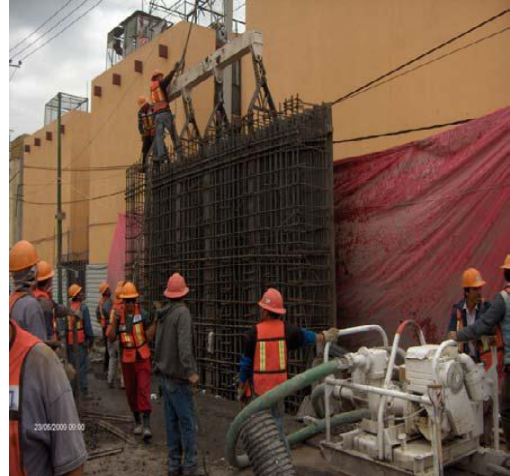
b) Armado e izaje del Muro Milán
