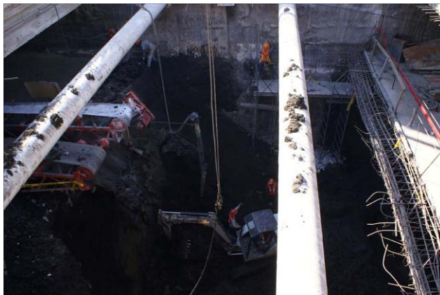
Figura 4.1. Excavacion hasta nivel de Mezzanine
