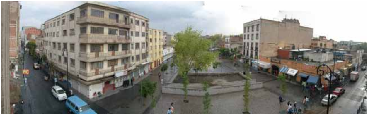
Panorámica de la plaza tomada desde el edificio de " La semillita" hacia el norte.
