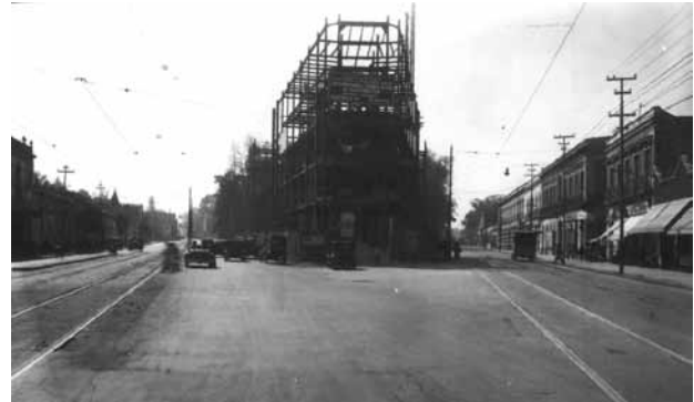
Fotografía de la estructura del Edificio Ermita durante su construcción, 1931
