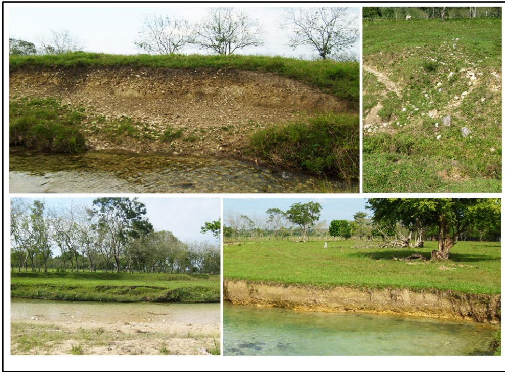
Figura 81.- Áreas de desborde y exposición de pisos de plataformas
