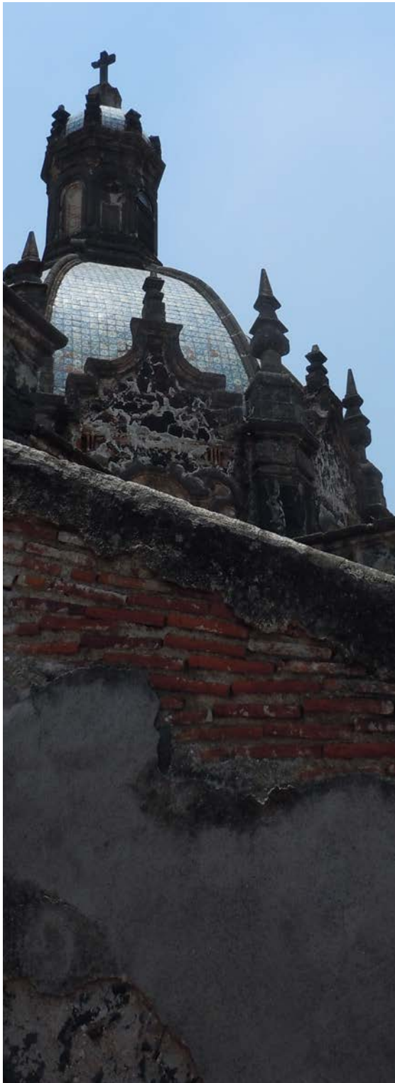
Figura 2. Cúpula y muro de fabrica heterogénea del Templo de El Carmen, México. Archivo personal.
