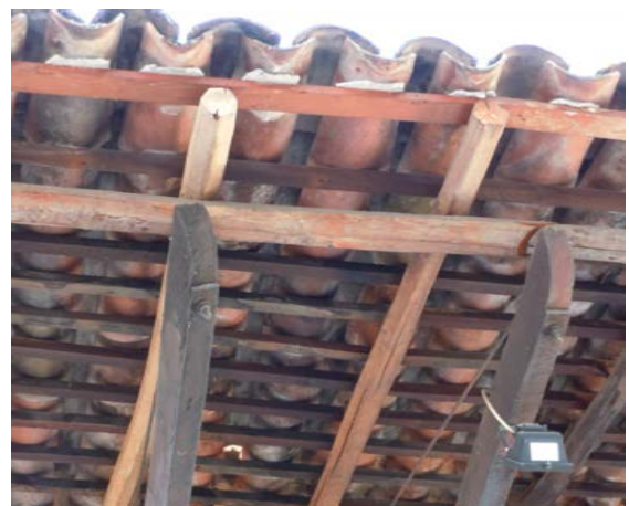
Figura 6. Colocación de las tejas en una cubierta. Archivo personal.
