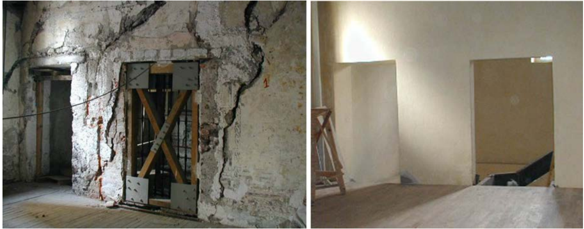
Figura 1. Reestructuración de un muro de cal y canto (mampostería de tezontle asentada con argamasa cal-arena) en el extemplo de Corpus Christi, Ciudad de México. Archivo personal.
