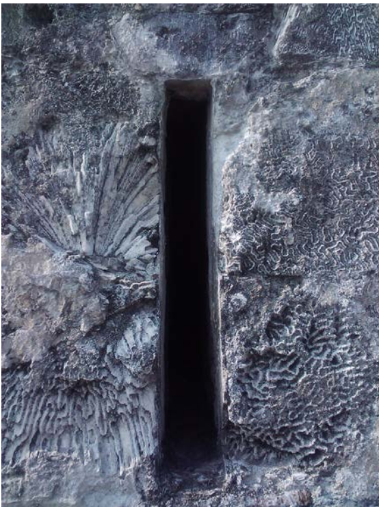
Figura 5. Piedra coralina (múcara) como material de construcción. Archivo personal.
