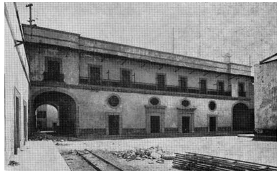
Figura 9. Fachada casa del Gobernador en 1920. Archivo INAH.
