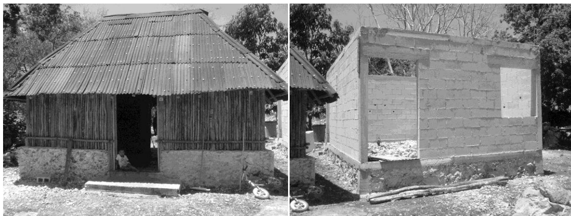
Figura 6.7. Plano del solar e imágenes de la casa principal y una casa en construcción del Grupo Doméstico 06 (fotos del autor).
