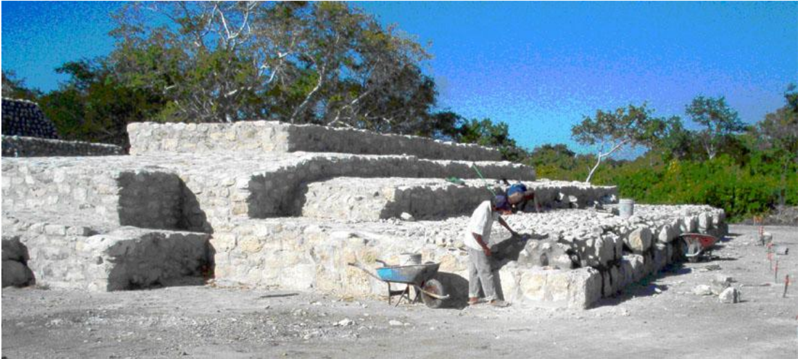
Figura 5.12. Edificio 6 de Jaina.
