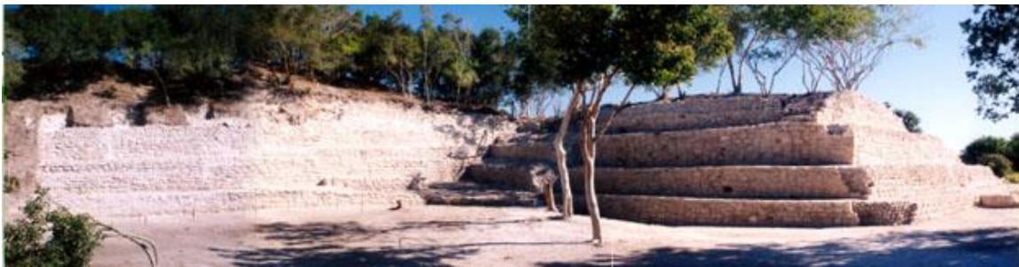
Figura 5.2. Edificio 1 del Grupo Zayosal visto desde el sur.
