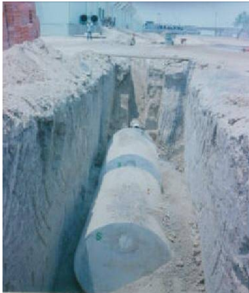
Img. 11 Filtros sanitarios
