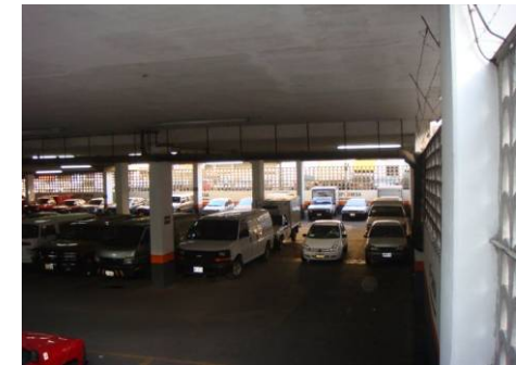
Img. 2 Vista del estacionamiento y columnas
