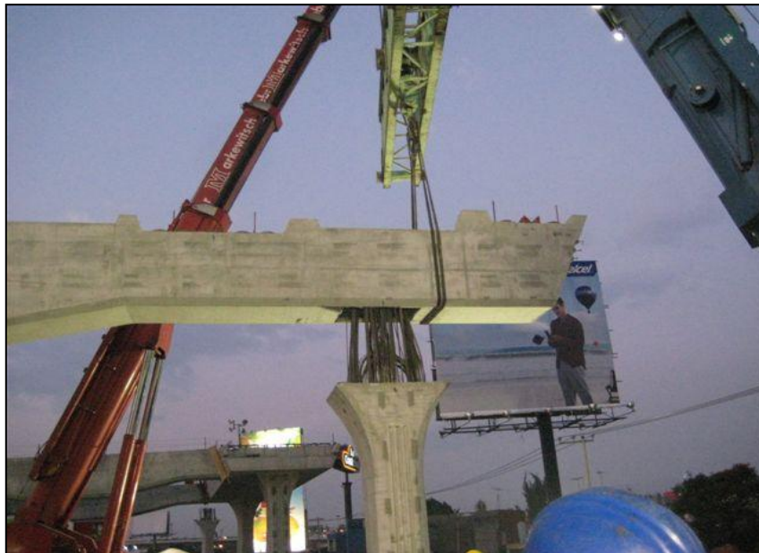
MONTAJE DE CBEZALES
