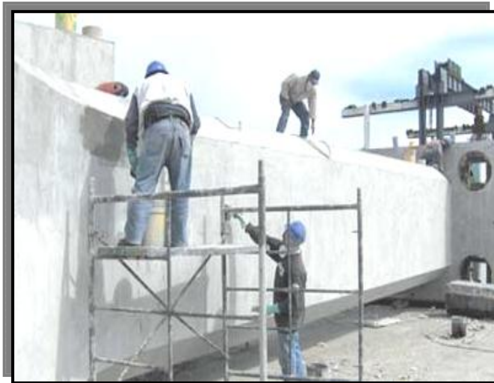
FABRICACIÓN DE ZAPATA-COLUMNA
