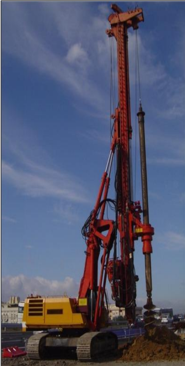
EQUIPO DE PERFORACIÓN
