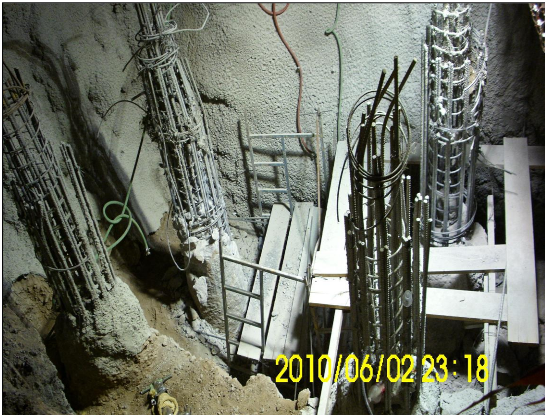
EXCAVACION PARA ZAPATA-COLUMNA
