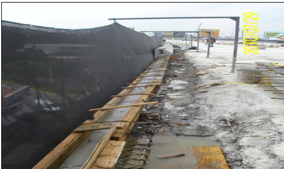
GROUT (GUARNICION) PARA NIVELACIÓN
