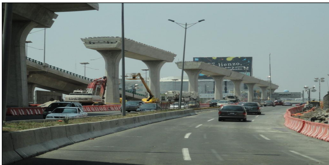
TRABES TA Y VARIANTES (APOYADA SOBRE COLUMNAS)
