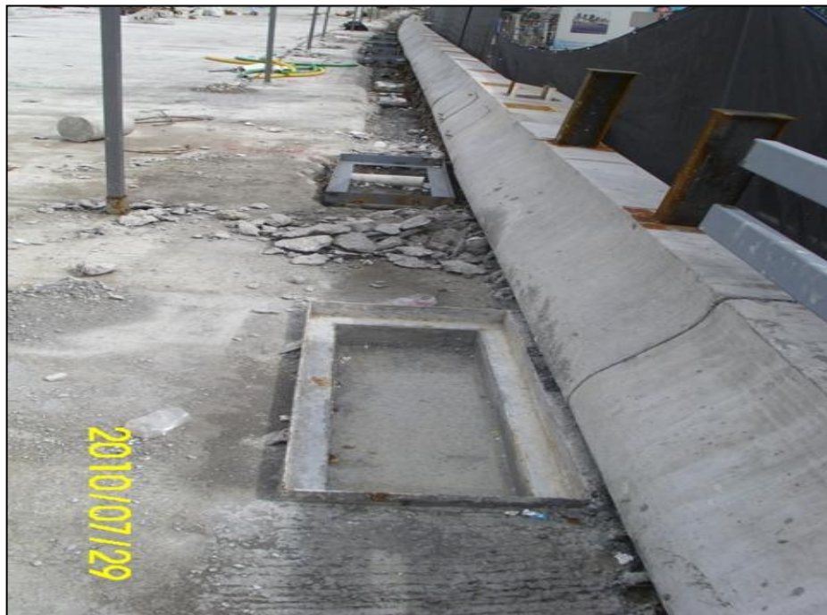
COLOCACIÓN DE BARANDAL
