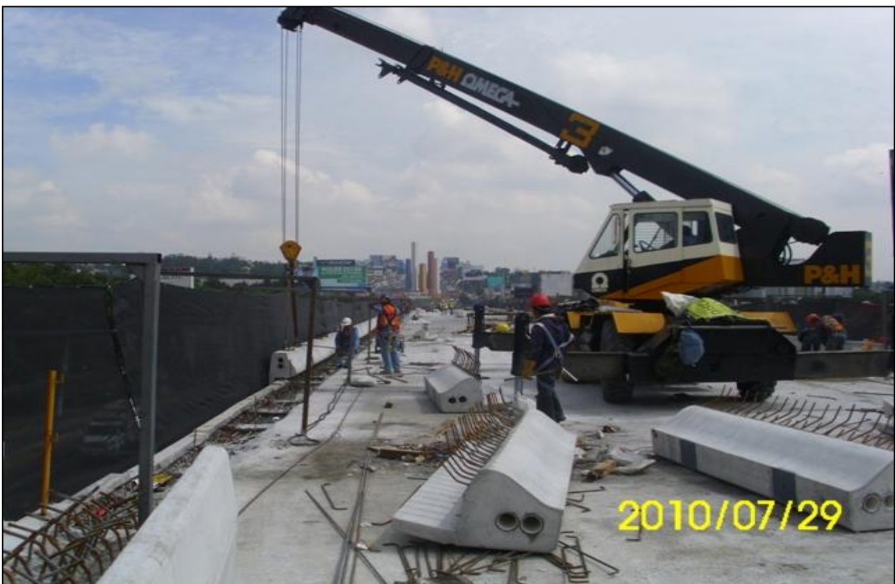
MONTAJE DE PARAPETO
