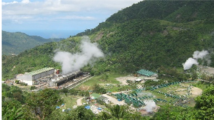
Figura 1.23: Central geotérmica Puhagan, Filipinas.
