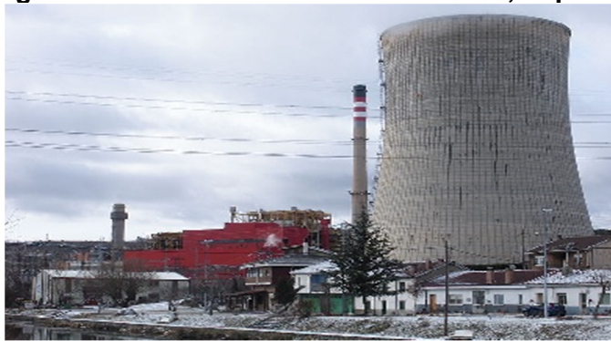
Figura 1.21 Central termoeléctrica Velilla, España.
