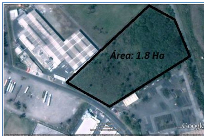
Figura 3.7 Terreno para la ubicación de la planta de biogás en Veracruz
