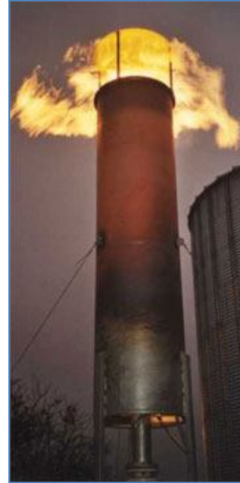
Figura 5.1 Antorchas para la quema de biogás (Moncayo, 2005)
