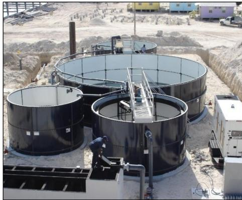
Figura 4.9 Sistema de lodos activados con aeración extendida
