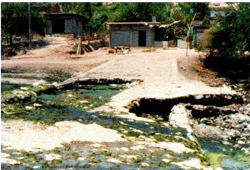
Foto XI.-Las condiciones de las redes de infraestructura en San Nicolás Zoyatlán constituyen un gran problema, como ejemplo, podemos mostrar el mal estado de los caminos y las condiciones del agua que es utilizada para el consumo humano
