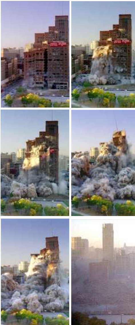
Ilustración 54 “Demolición edificio JL Hudson”, Lowell Boileau, Octubre 24, 1988, en “The Fabolous Ruins of Detroit”, http://www.detroityes.com/home.htm
