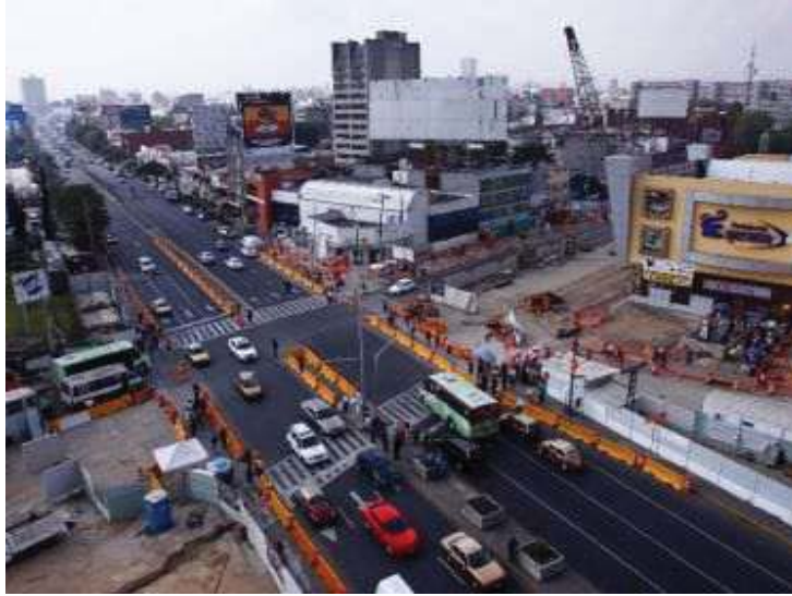
Fuente: Imagen tomada desde el edificio del STC en el Metro Zapata
