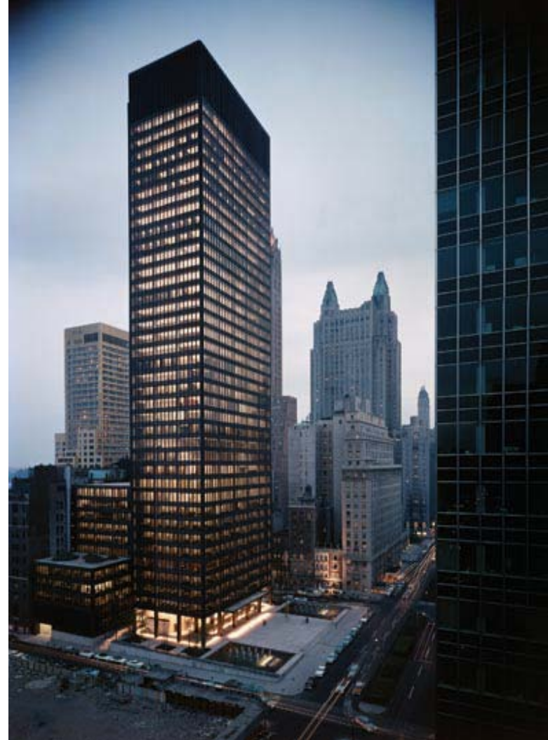
Edificio Seagram, New York, Mies Van der Rohe, ejemplo del razonamiento arquitectónico propuesto, el funcionalismo, el carácter universal y simple.
