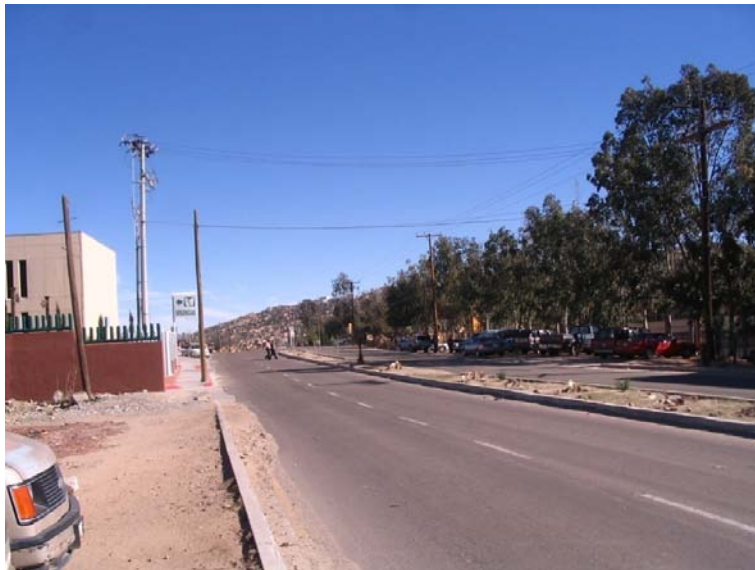
En la imagen podemos observar que se cuenta con dos sentidos con dos carriles cada uno, un camellón de 1.5 metros.
