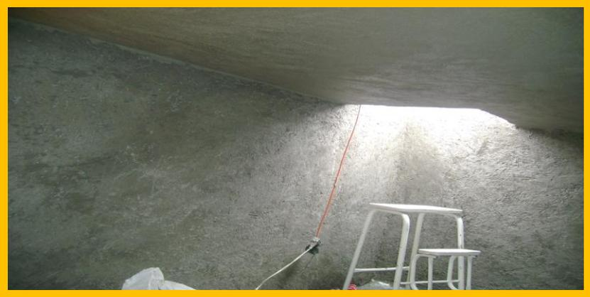
Foto 11.- Impermeabilización de tanque elevado
