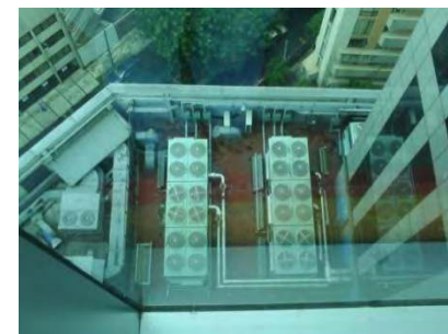
Vista aérea de sistema de despresurización
