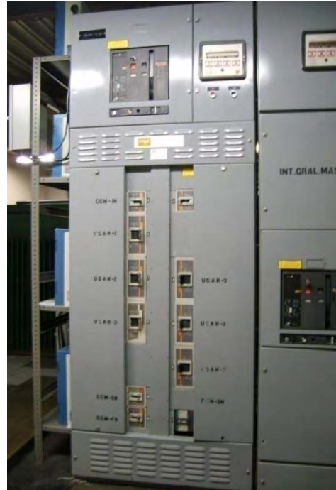
Caja de interruptores de planta de emergencia
