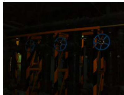
Válvulas de sistema de despresurización
