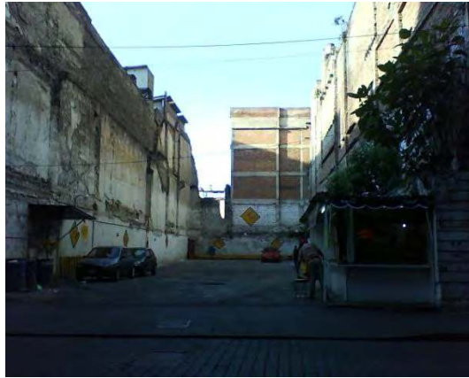
Estado actual Predio A
