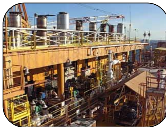
Figura 2.1 Vista del lado noreste del sistema de techumbre del área de las bombas
