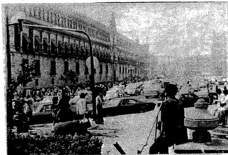
FIGURA VII.h. Nivelación de puntos de control en la fachada principal
