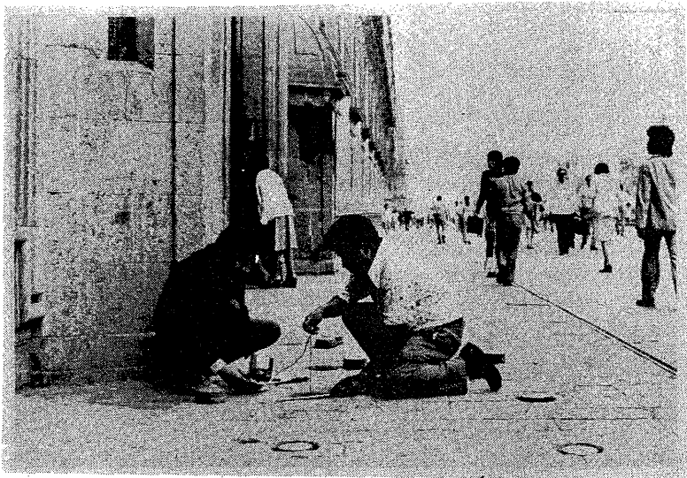
FIGURA VII.d. Operación en un piezómetro abierto
