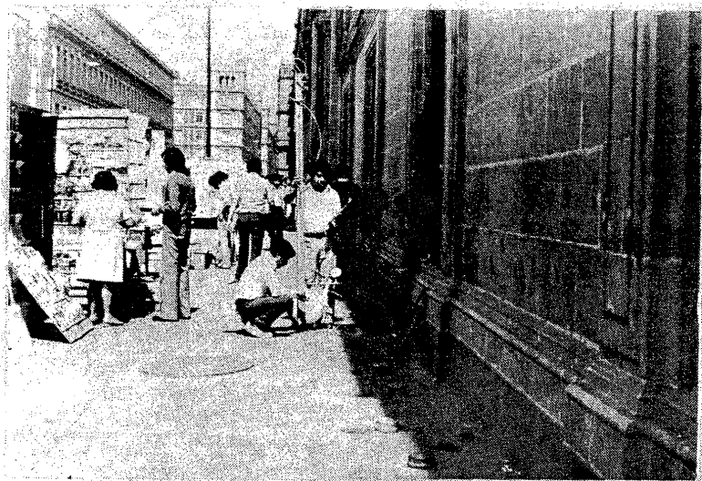
FIGURA VII.c. Personal operando para obtener lecturas de piezómetros neumáticos.
