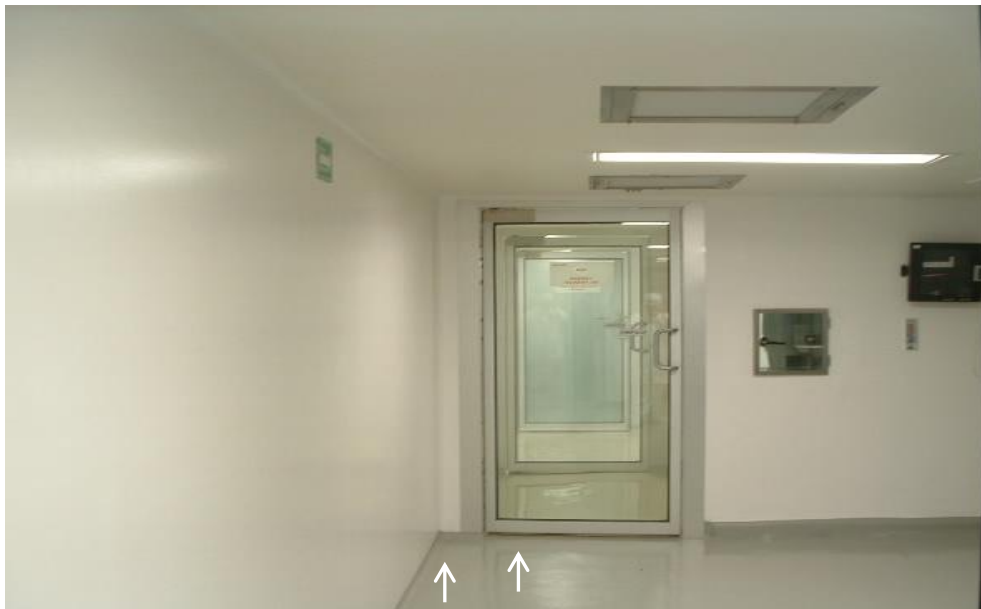
Imagen 11. Área de acondicionamiento, se indica con flechas la dirección en que se debe realizar la limpieza del piso.
