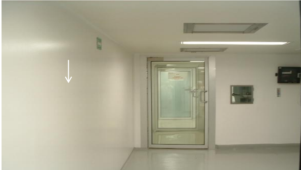
Imagen 10. Área de acondicionamiento, se indica con una flecha la dirección en que se debe realizar la limpieza de la pared.
