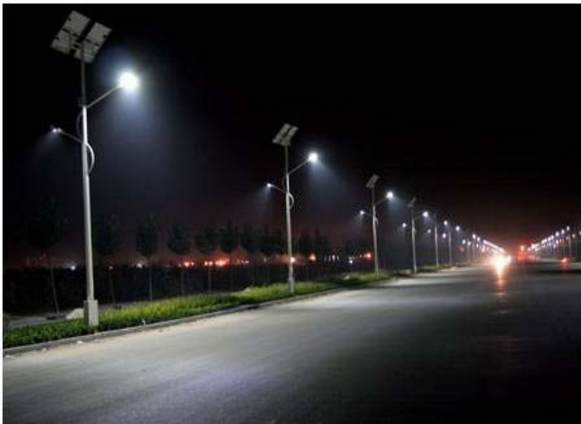
Fig.67 Lámparas para exteriores de LED con panel fotovoltaico
